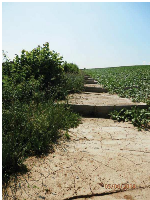
Figure 9 : Placette de démonstration des dispositifs d'interception des coulées d'eau boueuses à Schwindratzheim (67).
