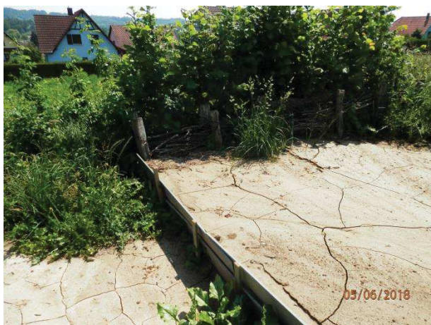
Figure 59 : Rétention des sédiments d'une coulée d'eau boueuse par un système fascine + haie vive.
