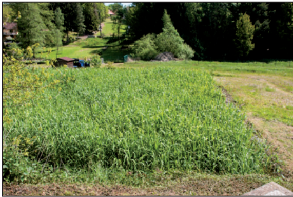
Figure 8. Premier étage de filtres plantés de roseaux (site A)
