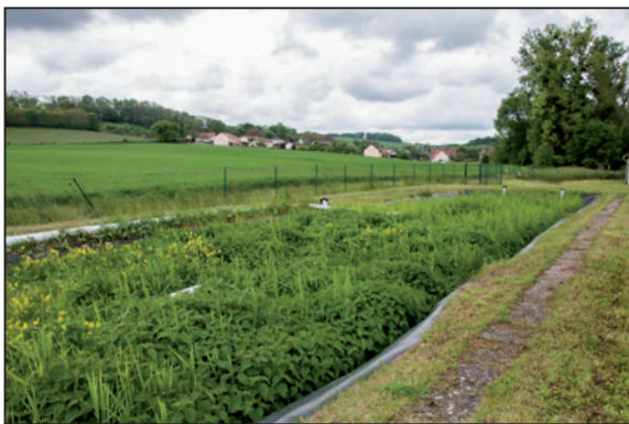
Figure 9. Premier étage de filtres plantés de roseaux (site B)
