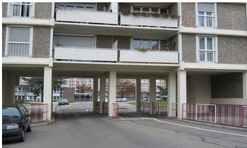
Photographie 1 : Porche sous la barre B, « ouverture » sur la Cité. Cliché : Thalès Architectures, 2004.
