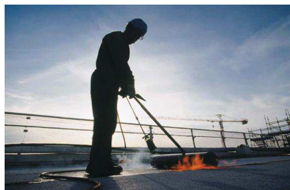
Figure 1 : Pose d'étanchéité bitumineuse
