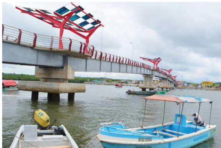
Figure 10 : Pont piéton de Muisne
