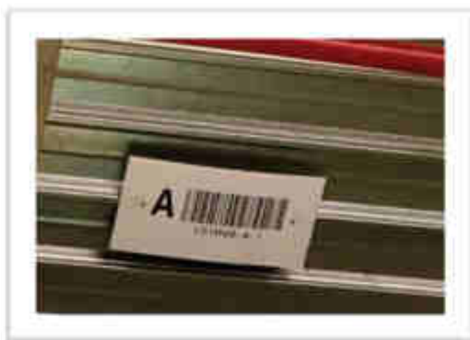
FIGURE 17. ETIQUETTE CODE-BARRES AIMANTEE FIXEE AU PLAFOND
