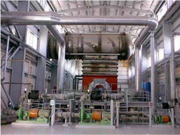
Fig. 6.18 – Turbines servant à la conversion de la vapeur d'eau à 230 °C en électricité (source LaGeo).
