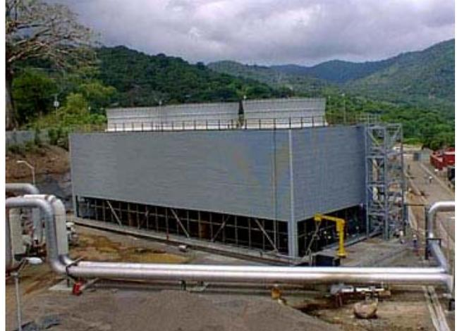
Fig. 6.19 – Condensateurs servant à refroidir la vapeur d'eau (source LaGeo).
