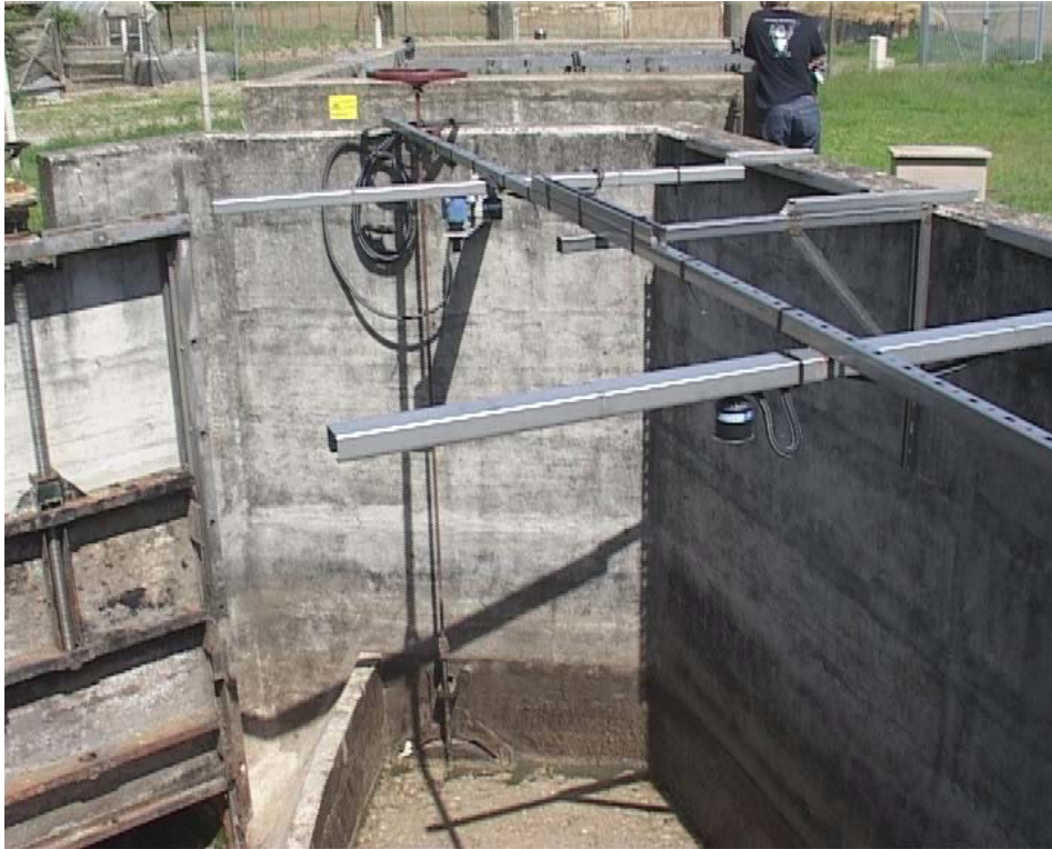
Figure 7-1 : Capteurs ultrasons du DO 1
