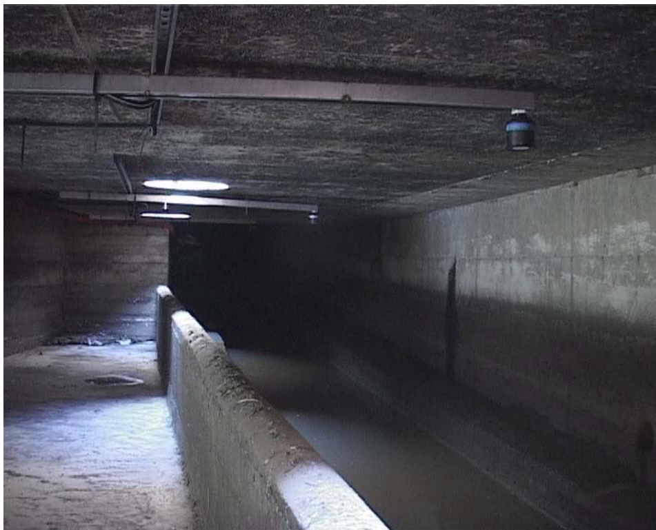
Figure 7-2 : Capteurs ultrasons du DO A
