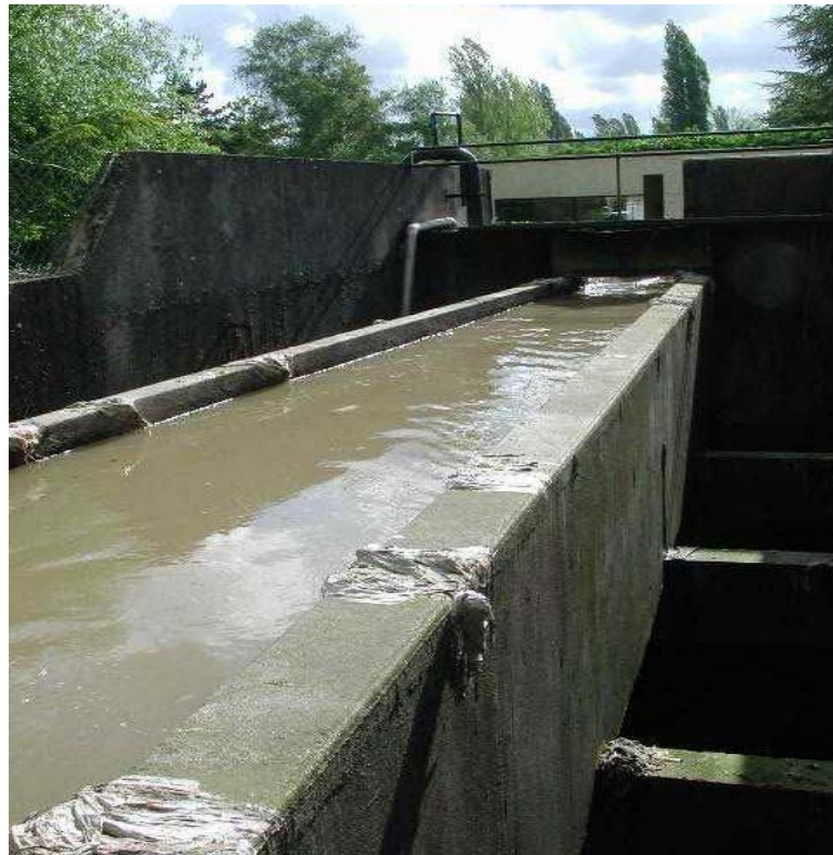
Figure 3-5 : Vue vers l'aval du déversoir
