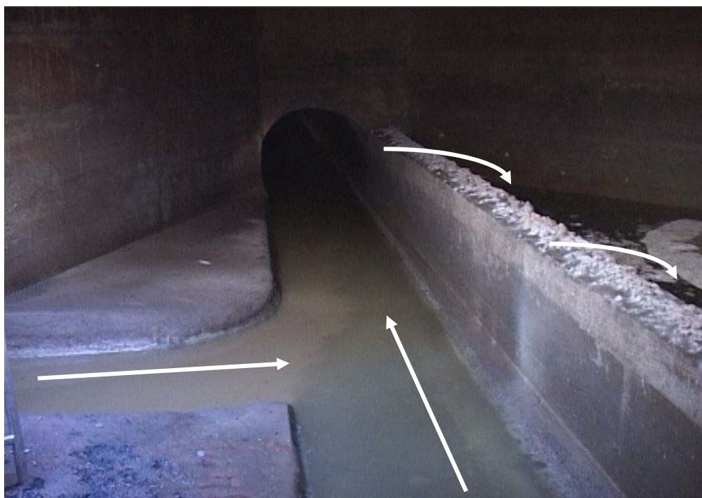
Figure 1-11 : Déversoir du réseau de Sélestat (DO E)
