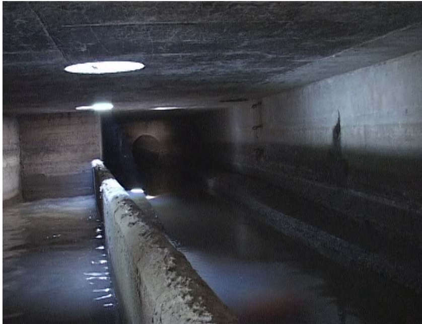
Figure 3-32 : Déversoir latéral du réseau de Sélestat (DO A)
