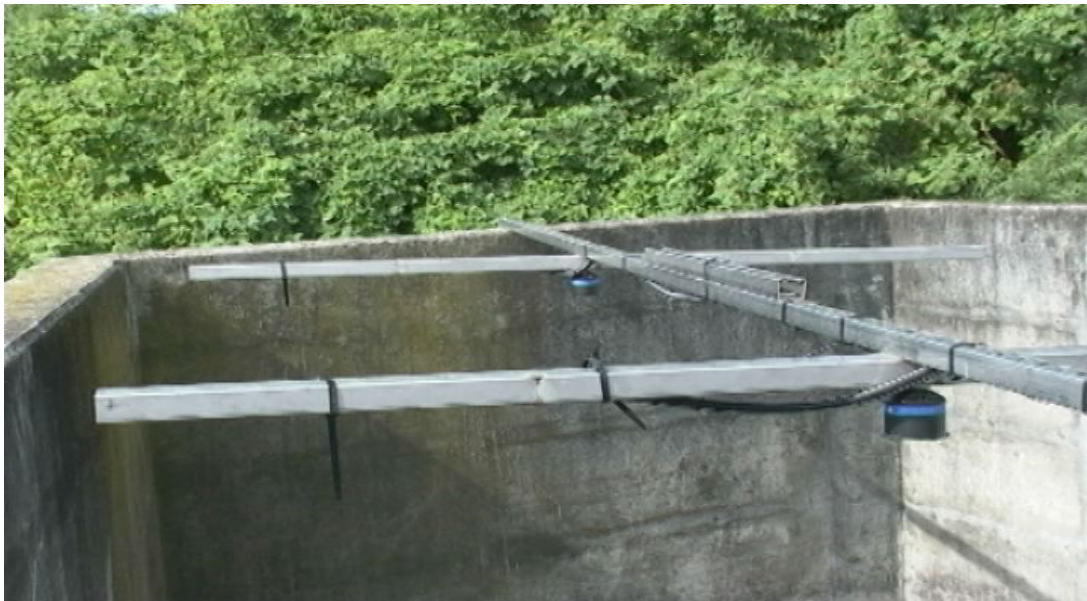
Figure 3-45 : Exemple d'installation sur rail
