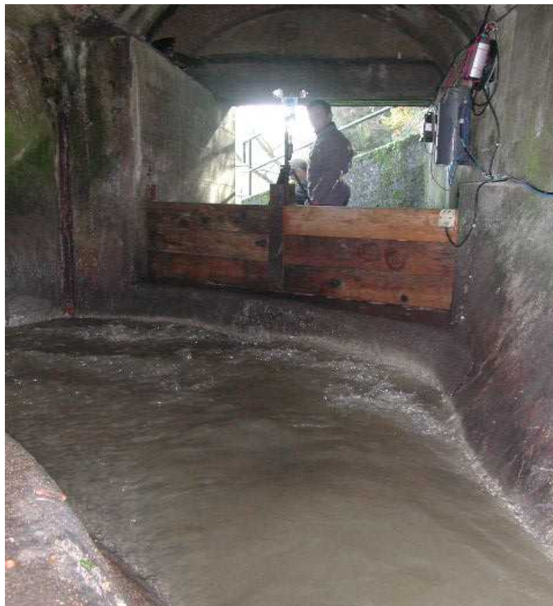
Figure 3-10 : Surélévation du batardeau au niveau du coude
