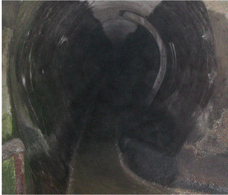
Figure 3-3 : Le collecteur d'apport vu vers l'amont, au niveau du batardeau
