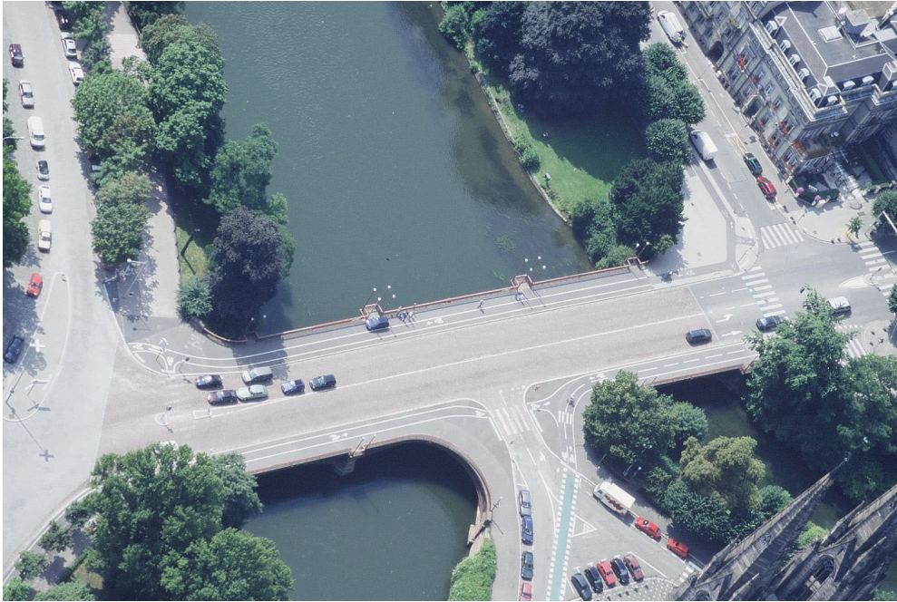
Figure 2.6 Site de mesures du Pont Royal
