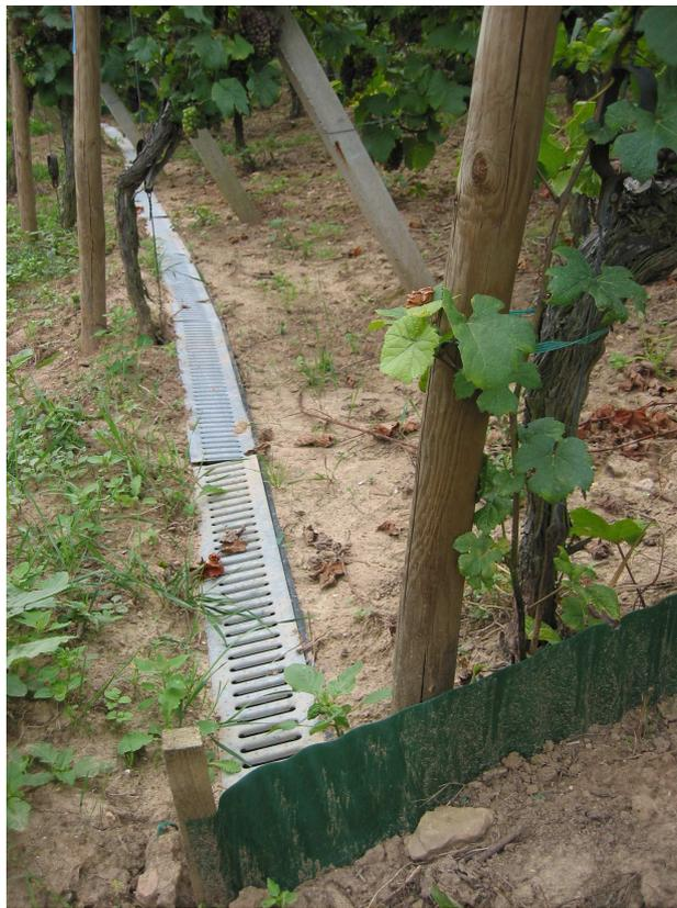
**Photo 2 : Caniveau collecteur du ruissellement des placettes et isolation hydraulique**
