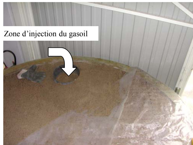
Figure 31 : Zone d'injection du gasoil (guidage par un tube).
