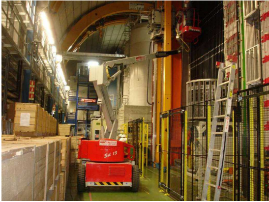
FIG. 5.34 : Accès aux PM des modules horizontaux par les côtés via l'utilisation d'une nacelle élévatrice.
