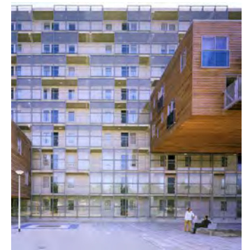
Amsterdam, WoZoCo La façade nord, détail des "boîtes" et coursive MVRDV architectes Source: El Croquis , MVRDV 1991-2002, éditions El Croquis
