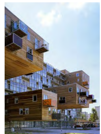
Façade nord Amsterdam, Wozoco MVRDV, architectes Source : El Croquis, MVRDV, 1991-2002, éditions El Croquis
