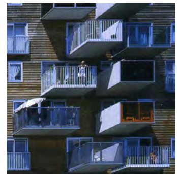
Amsterdam, WoZoCo La façade sud, MVRDV architectes Source: El Croquis , MVRDV 1991-2002, éditions El Croquis
