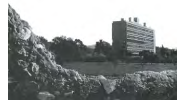
Marseille. La Cité Radieuse dans son paysage initial Le Corbusier, architecte Source : Le Corbusier, œuvre complète, volume 5, Les éditions d'architecture, Artémis, Zurich
