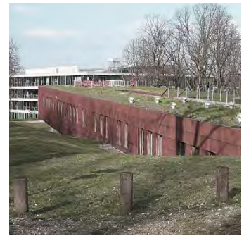
RVU building, Hilversum Crédit photographique Franck Guéné
