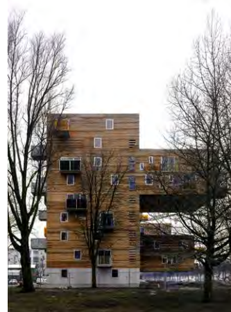
Amsterdam, WoZoCo La façade est, MVRDV architectes Source: El Croquis , MVRDV 1991-2002, éditions El Croquis
