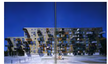
Amsterdam, WoZoCo La façade sud MVRDV architectes Source: El Croquis , MVRDV 1991-2002, éditions El Croquis
