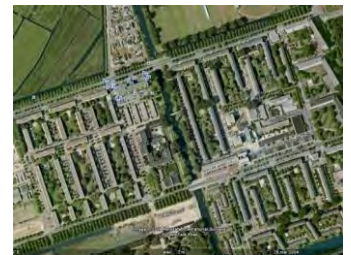
Amsterdam, le quartier d'Osdorp et le projet WoZoCo Source http://www.earth.google.fr
