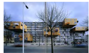
Amsterdam, WoZoCo La façade nord MVRDV architectes Source: El Croquis , MVRDV 1991-2002, éditions El Croquis
