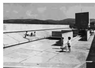
Firminy, la Cité Radieuse, la toiture -terrasse Le Corbusier architecte Source : Le Corbusier, œuvre complète, volume 8 , Les éditions d'architecture, Artémis, Zurich
