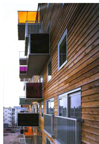
Amsterdam, WoZoCo La façade sud, MVRDV architectes Source: El Croquis , MVRDV 1991-2002, éditions El Croquis
