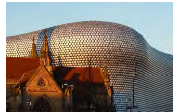
Birmingham, Selfridges building, Futur System, architectes Source L'Architecture d'aujourd'hui , n°349, novembre décembre 2003
