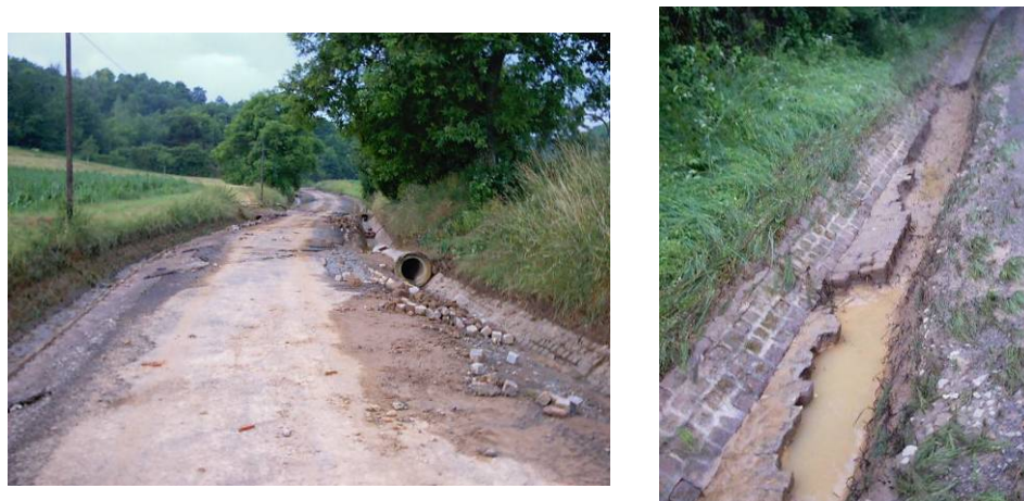
Figure 2.12 : Atteinte au réseau d'écoulement lors d'une coulée boueuse à Soultz les Bains (Alsace – Clichés : Région Alsace, 2003)
