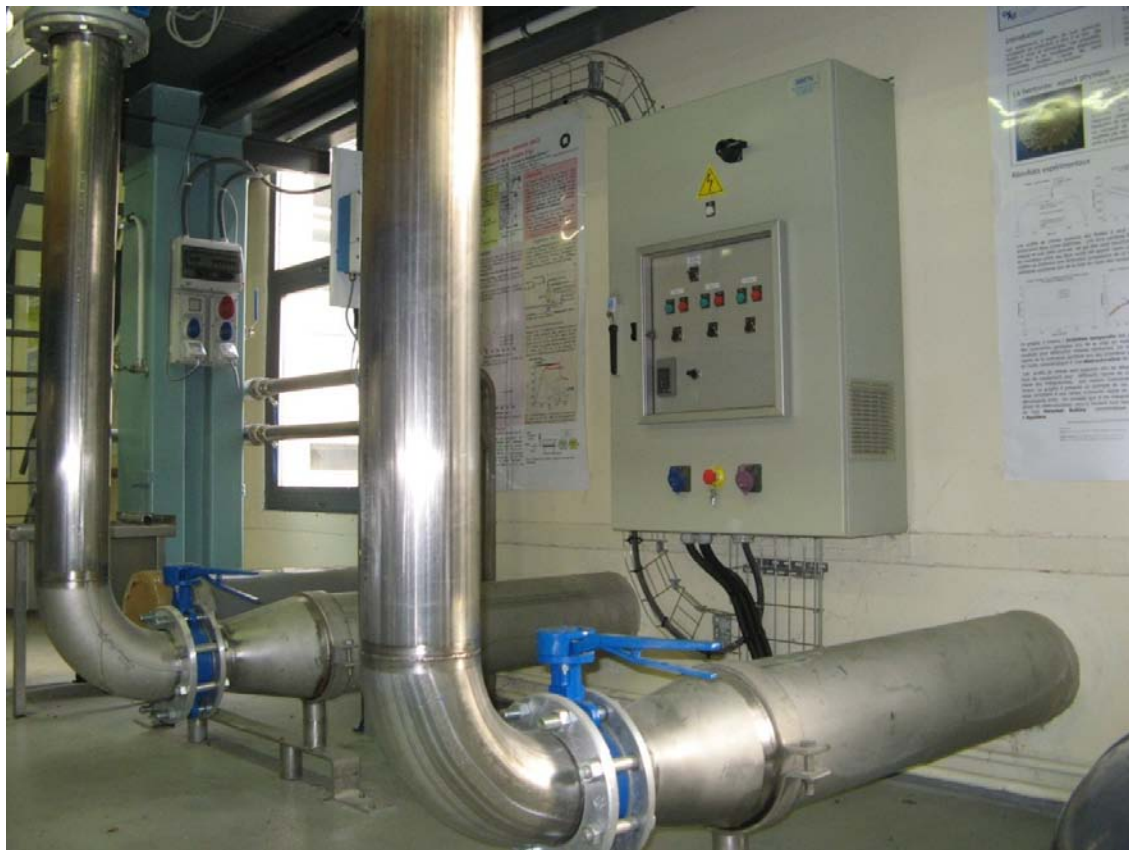
Figure 8-4 Partie verticale des conduites d'alimentation
