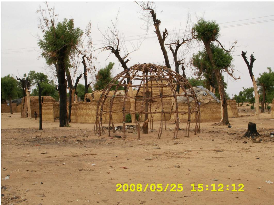
**Figure n°2.11** : Les paillotes et une charpente de paillote en reconstruction après un incendie
