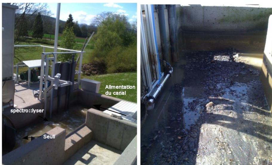
Fig. 4.2 – Photos du spectro::lyser installé en entrée de la station de traitement des eaux usées de Rosheim
