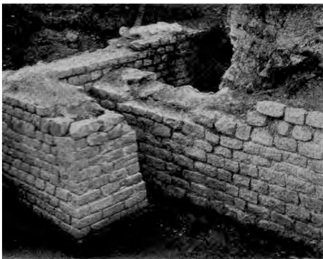
Fig. 100 : Murs maçonnés (Forrer 1911, pl. III, fig. 4)
