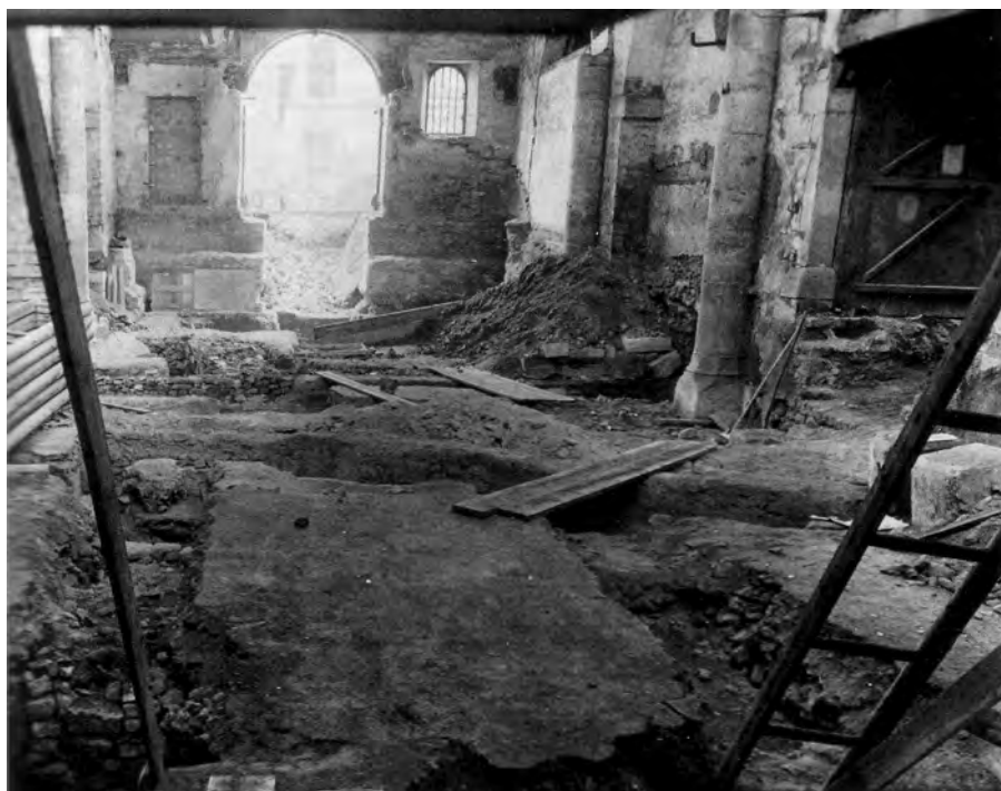
Fig. 249 : Vue des fouilles de Saint-Pierre-aux-Nonnains de Metz réalisées en 1943 (Delestre 1988, p. 17)
