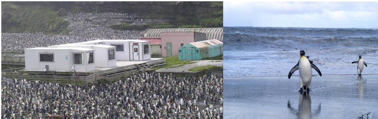
Figure II.5. Au milieu de la colonie, quatre bâtiments préfabriqués abritent les installations scientifiques. Depuis le radier sur lequel sont installés ces shelters , il est possible de surveiller le retour à terre des manchots royaux.
