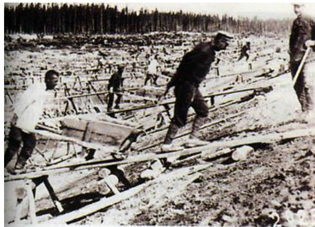
Construction d'un canal par des prisonniers de GOULAG (1932)
