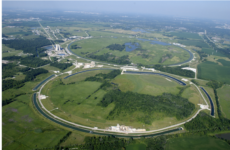
FIGURE II.1 – Vue aérienne du Tevatron au Fermilab.
