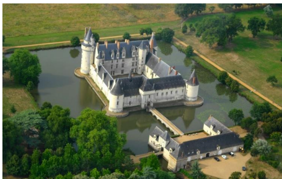
Figure 149: Château de Coullaine, XV e siècle, commune de Beaumont-en-Véron, Indre-et-Loire.
