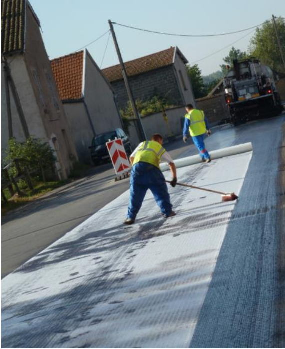
Figure a1. Mise en place de la grille sur la couche d'accrochage
