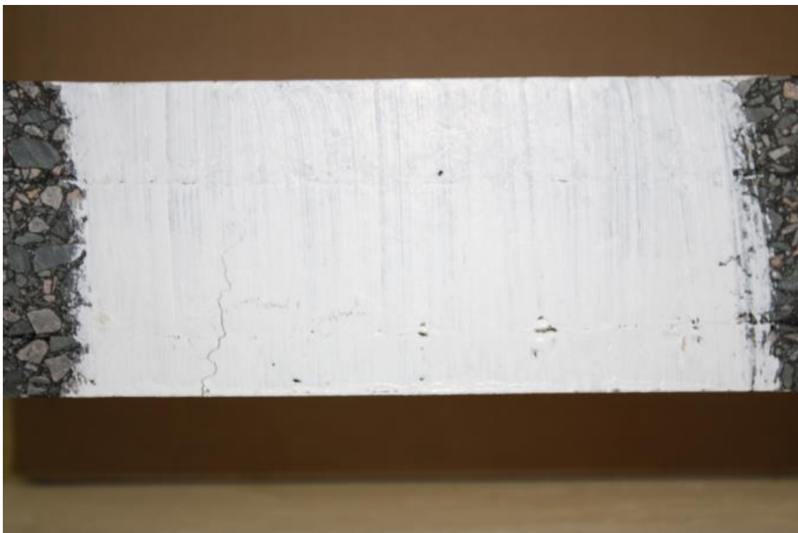
Figure 4.30 Etat de fissuration à 0h de flexion de la poutre 15R, post essai de fatigue à \epsilon = 129 \mu\text{m/m}
