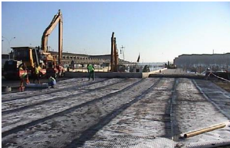
Figure 1.11. Chantier de géo-grille au Port Lorient, décembre 2001(photo 6D Solution)
