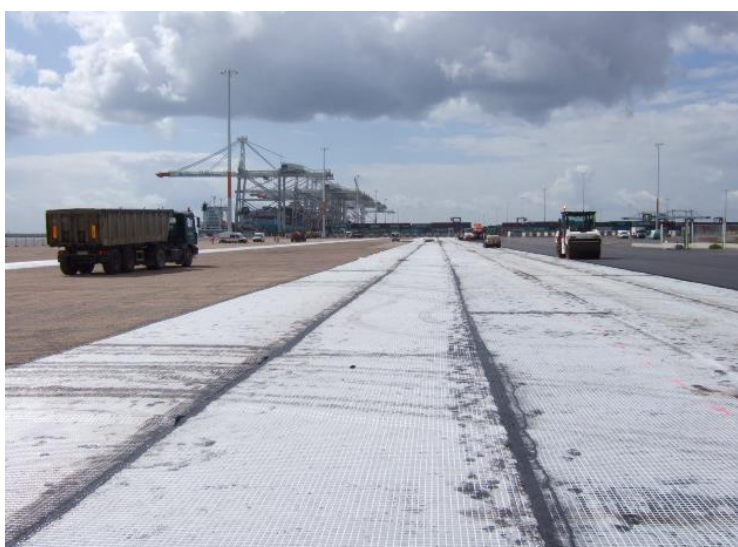
Figure 1.13. Renforcement d'une plateforme portuaire - Port Autonome du Havre (photo I.A)
