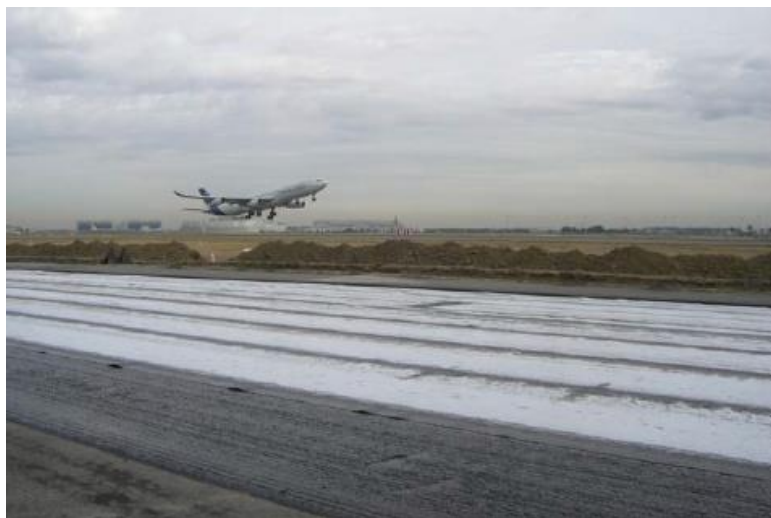
Figure 1.12. Chantier de géo-grille à l'Aéroport Toulouse Blagnac, octobre 2010 (photo 6D Solution)
