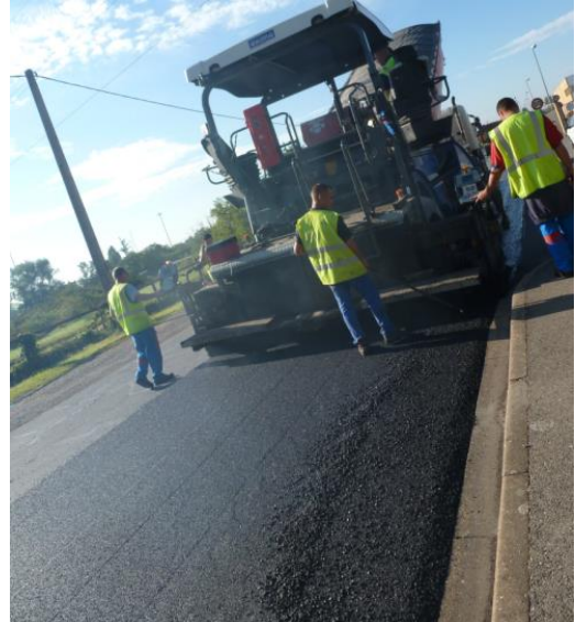
Figure a3. Passage du finisseur et réalisation de la couche de roulement en béton bitumineux
