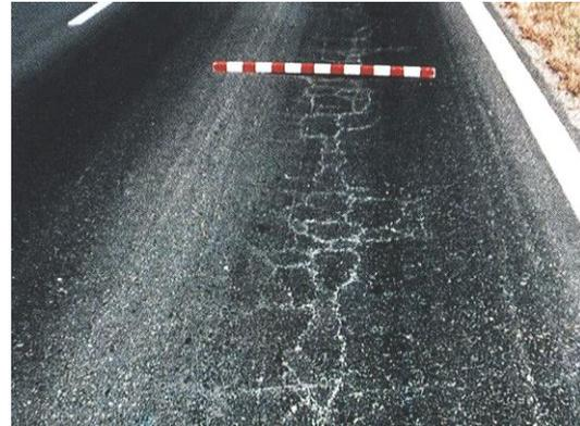
Figure I.4. Fissuration de la chaussée
