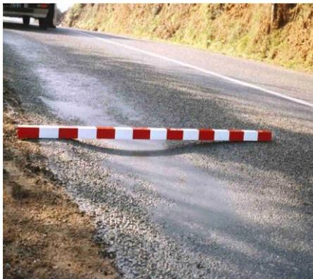
Figure I.3. Orniérage de la chaussée
