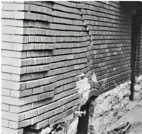
**Figure 1.1** – *Rupture fragile d'une structure maçonnée.*
