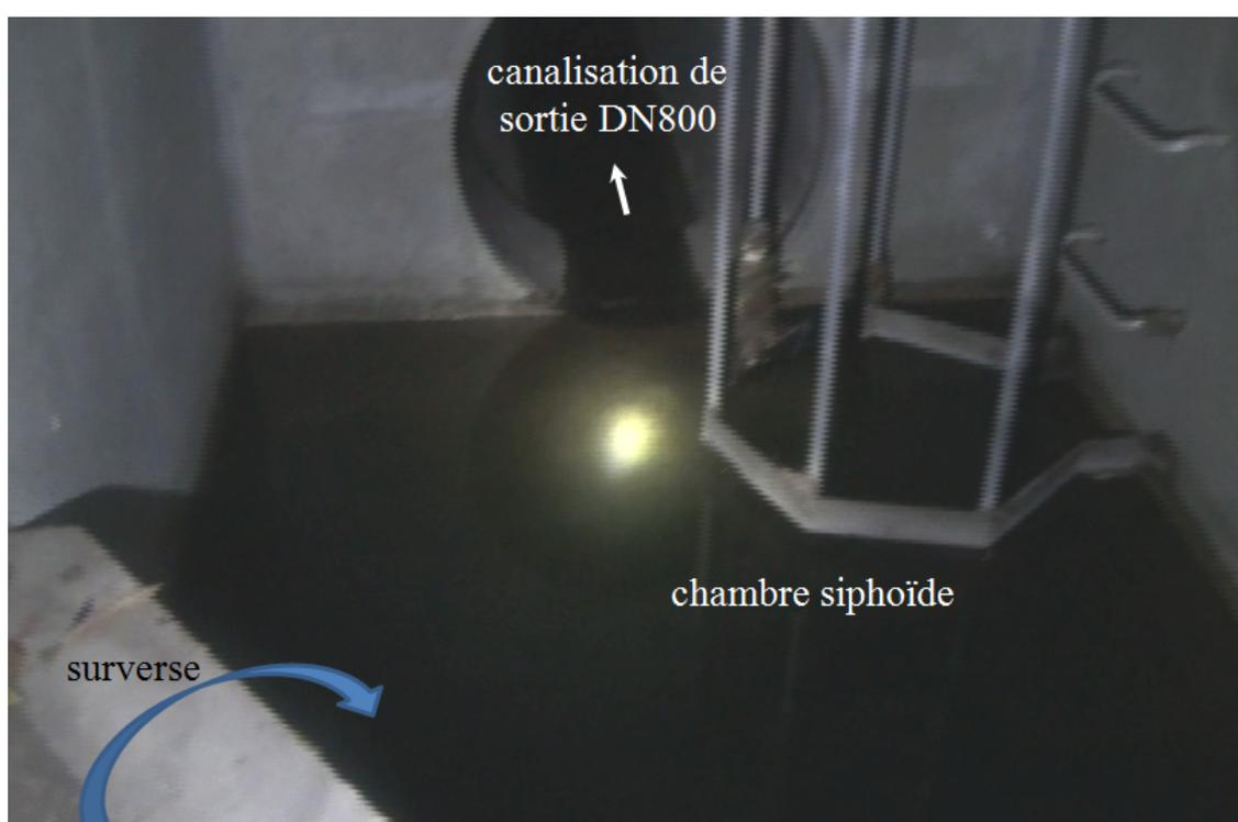
*Figure 212. Chambre siphonide et canalisation de sortie de l'ouvrage*
