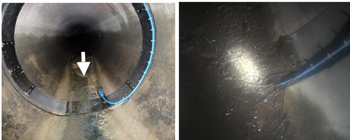
*Figure 210. Installation du capteur Doppler continu dans la conduite le 12 octobre 2011 (à gauche) et visualisation du dépôt sur le capteur le 13 janvier 2013 (à droite)*
