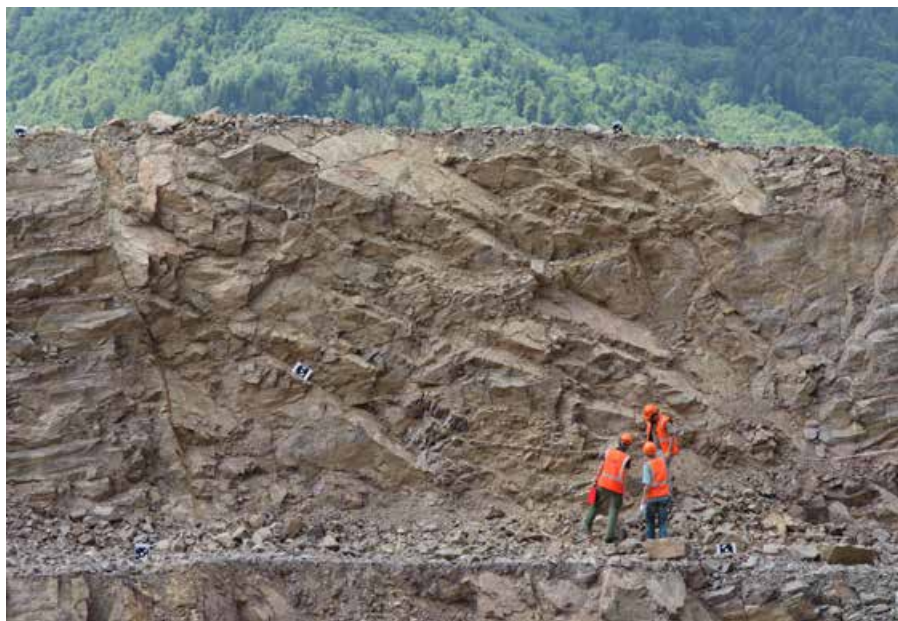
FIGURE IV-1.15 – Mesures “à la ficelle” sur le gradin supérieur du site de Saint-Jeoire - On distingue, disposées sur la paroi, en pied et en crête, des cibles utilisées pour les traitements photogrammétriques.
