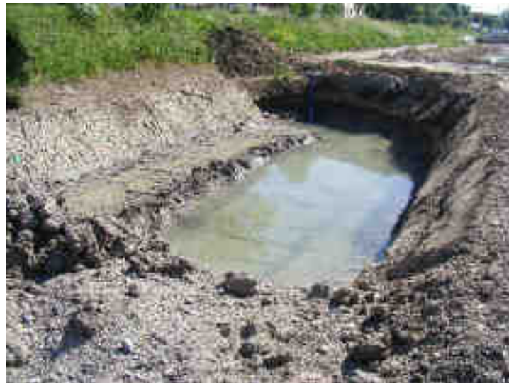
Figure 4-17. Filtre n°1 - Mise en place de la couche d'étanchéité (le 29/05/12)
