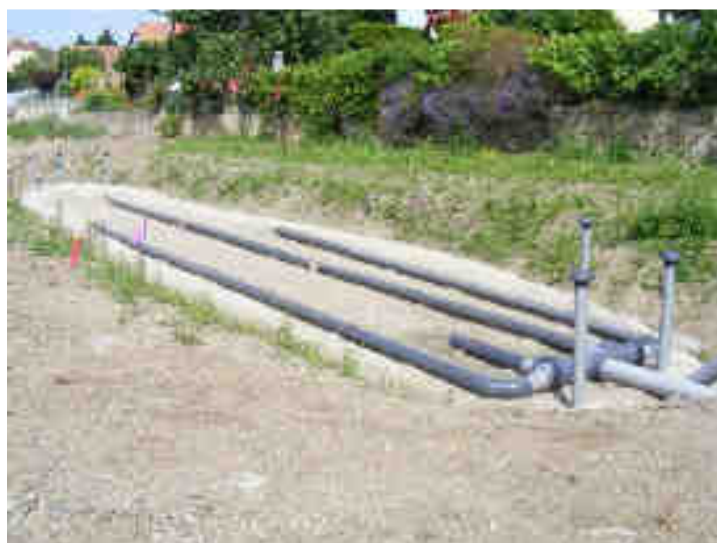
Figure 4-23. Filtre n°3 - Dispositif d'alimentation avec quatre branches de répartition du flux (le 26/06/12)
