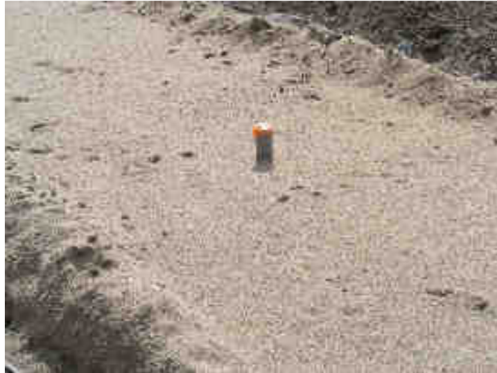
Figure 4-22. Filtre n°3 - Piézomètre atteignant le fond du filtre (le 02/05/2012)
