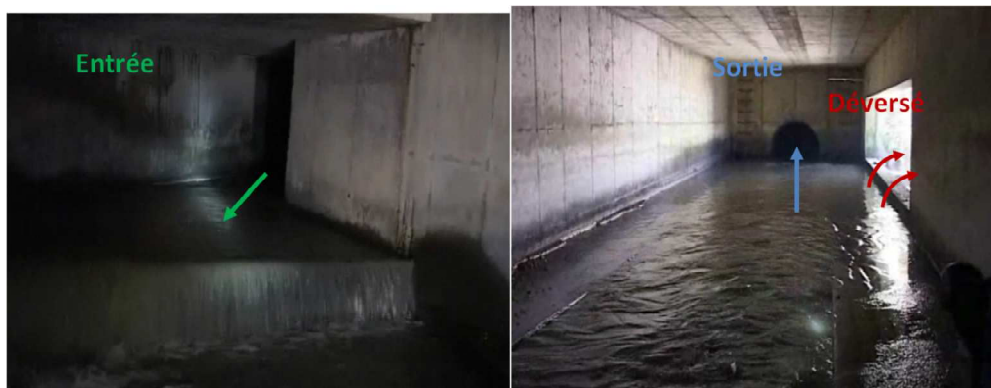
FIGURE 5.1: Le déversoir d'orage d'Herbet
