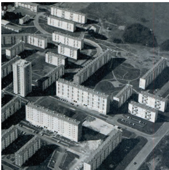
a. Parcellaire actuel, géoportail 2013. b. Vue aérienne de Valentigney / Techniques et Architectures , 1962.
