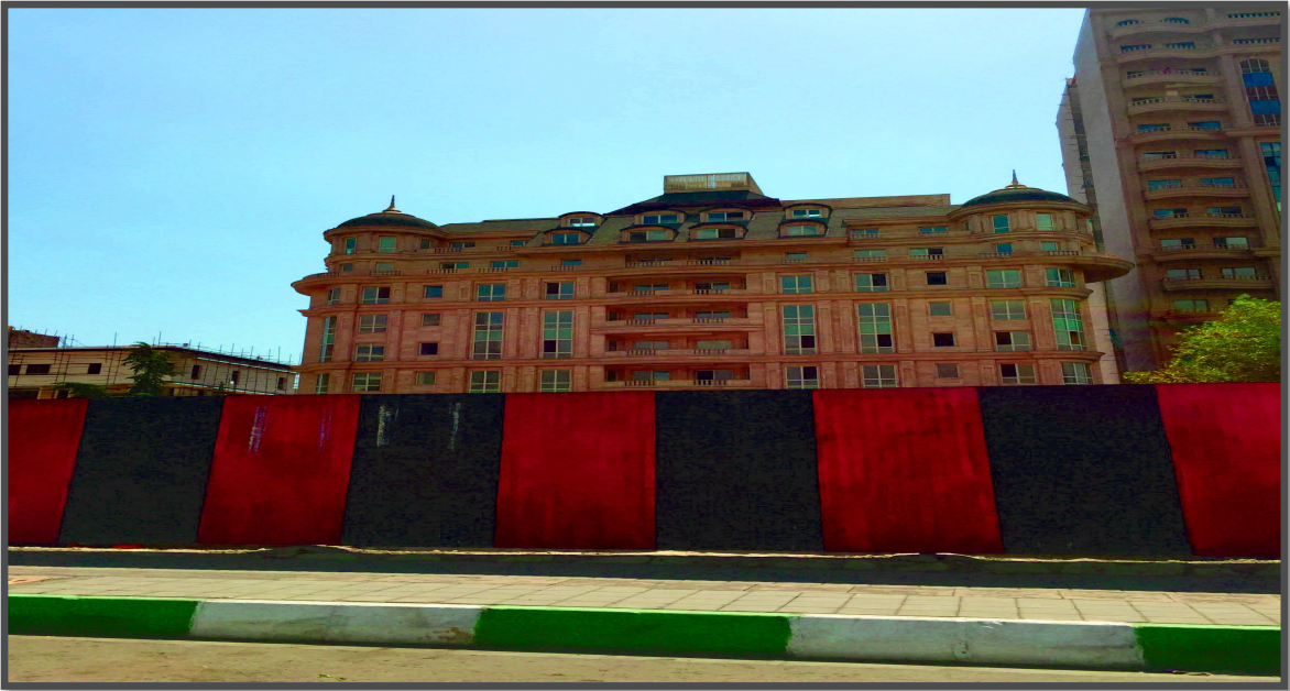
Photo 26: Matériaux de construction; Photo: AZARI 2014
