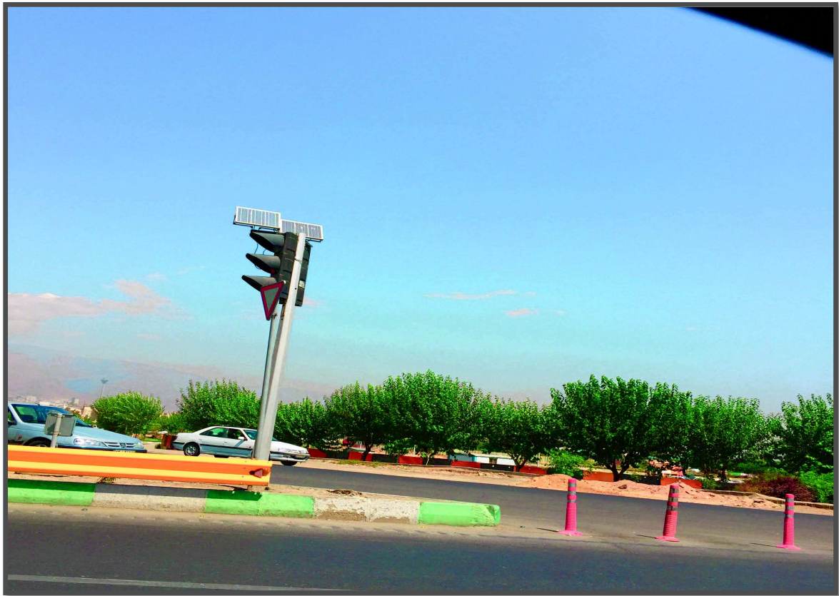
Photo 31: Concept d'énergie renouvelable à Téhéran – l'énergie des feux rouges est fournie par des installations photovoltaïques ; Photo : AZARI 2015
