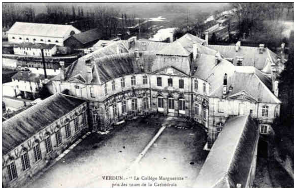
Figure 168 : Photographie du bâtiment accueillant les cours secondaires de jeunes filles puis le collège de jeunes filles de Verdun (carte postale, début XX e siècle, coll. part.).
