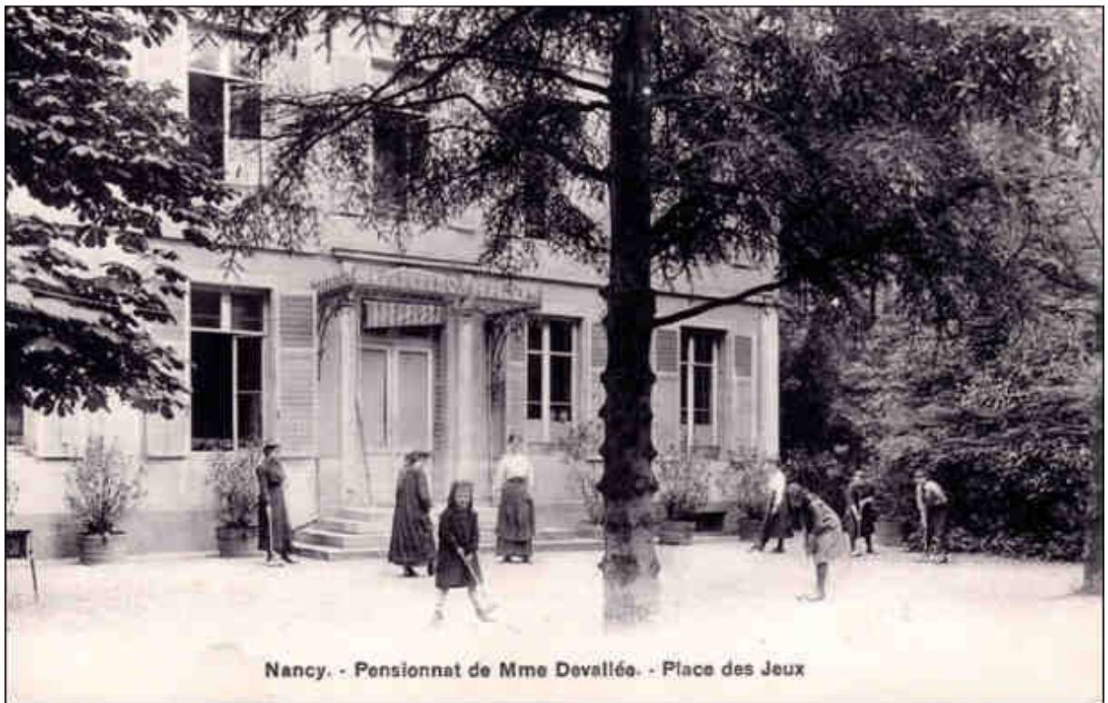
Figure 216 : Photographie du bâtiment des cours Devallée à Nancy, appelés ici « pensionnat » (carte postale, début XX e siècle, coll. part.).
