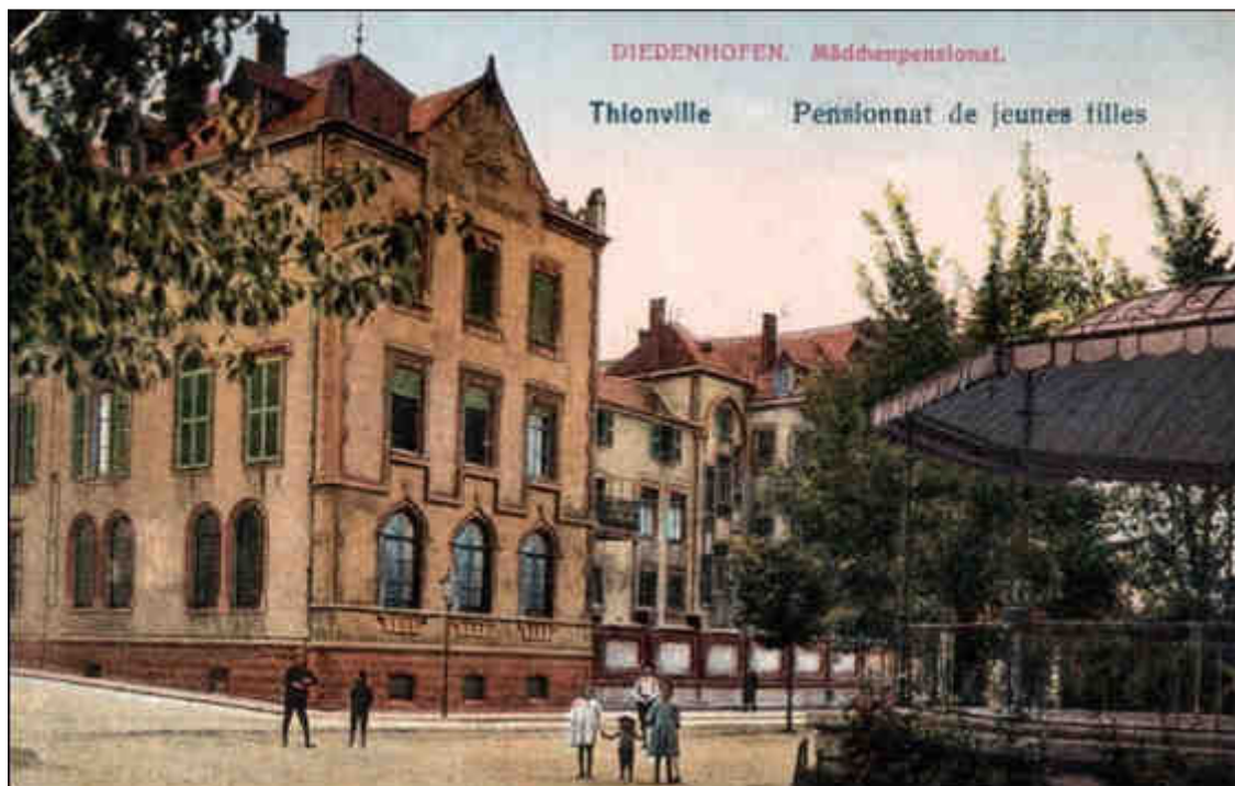
Figure 178 : Photographie du bâtiment de l'école supérieure de filles des Sœurs de la Providence de Peltre à Thionville (carte postale colorisée, début XX e siècle, coll. part.).
