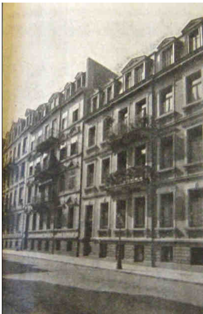
Figure 155 : Photographie de la façade du bâtiment construit en 1894 pour l'école supérieure de filles Koebig à Strasbourg (illustration du papier à lettre de l'établissement, ADBR 34AL1410).
