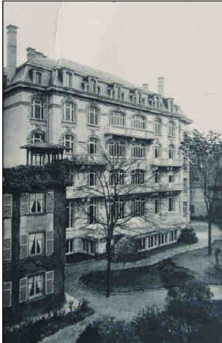
Figure 152 : Photographie de la façade principale du bâtiment construit en 1906 pour y transférer l'internat de l'école supérieure de filles du Bon-Pasteur à Strasbourg, avec, au premier plan à gauche, une partie du bâtiment de 1879, surmonté de la tourelle bâtie en 1886 (carte postale, début du XX e siècle, AMS 300Fi202a).
