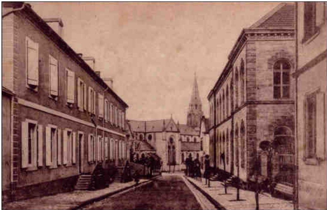
Figure 177 : Photographie du bâtiment – à gauche – de l'école supérieure de filles des Sœurs de la Providence de Peltre à Forbach (carte postale, vers 1900, coll. part.).
