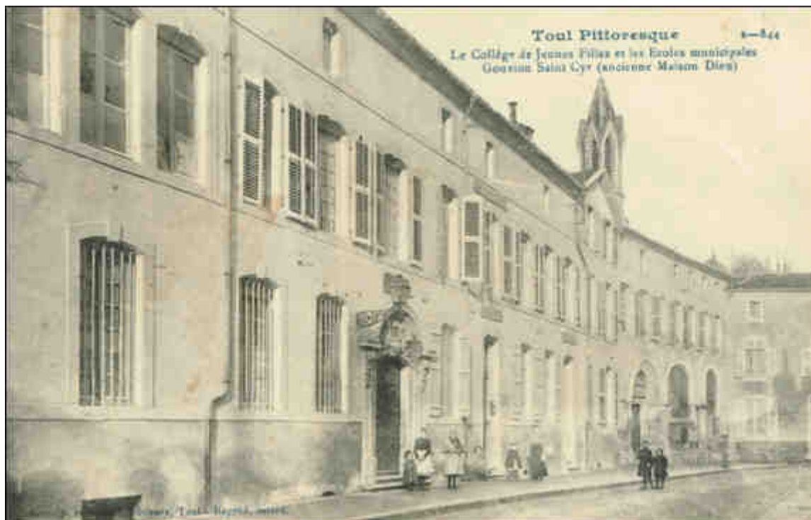
Figure 164 : Photographie du bâtiment accueillant, à partir de 1903, les cours secondaires de jeunes filles puis le collège de jeunes filles de Toul (carte postale, début XX e siècle, coll. part.).
