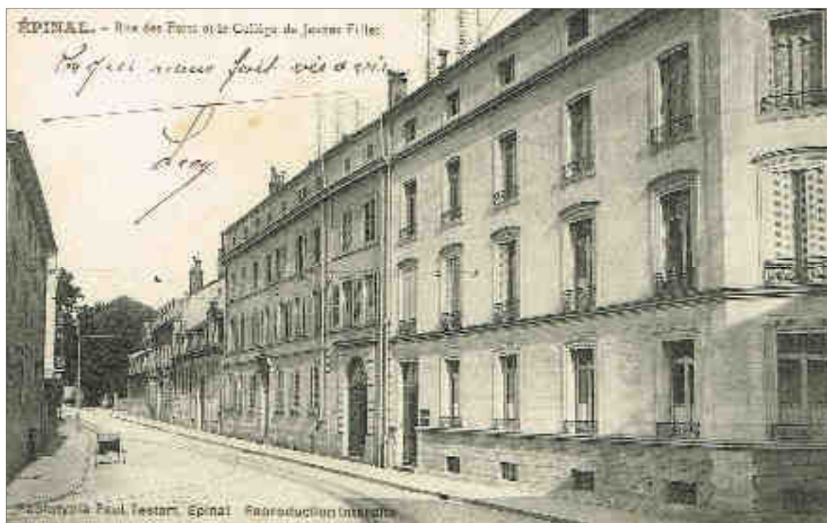
Figure 176 : Photographie du bâtiment accueillant le collège de jeunes filles d'Épinal (carte postale, début XX e siècle, coll. part.).
