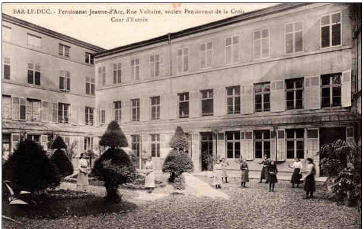
Figure 210 : Photographie du bâtiment de l'ancien pensionnat des Dames de la Croix à Bar-le-Duc, sécularisé en Pensionnat Jeanne-d'Arc (carte postale, début XX e siècle, coll. part.).
