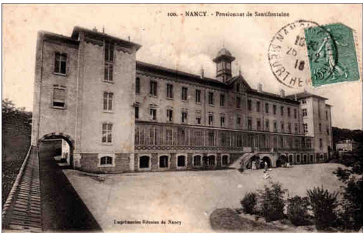
Figure 146 : Photographie du bâtiment construit en 1904 pour abriter l'internat du lycée de jeunes filles de Nancy (carte postale, début XX e siècle, coll. part.).
