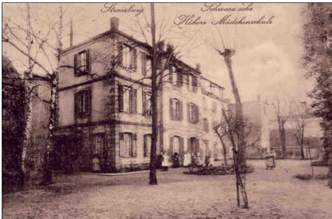
Figure 190 : Photographie du bâtiment de l'école supérieure de filles Schwartz à Strasbourg (carte postale, début XX e siècle, coll. part.).
