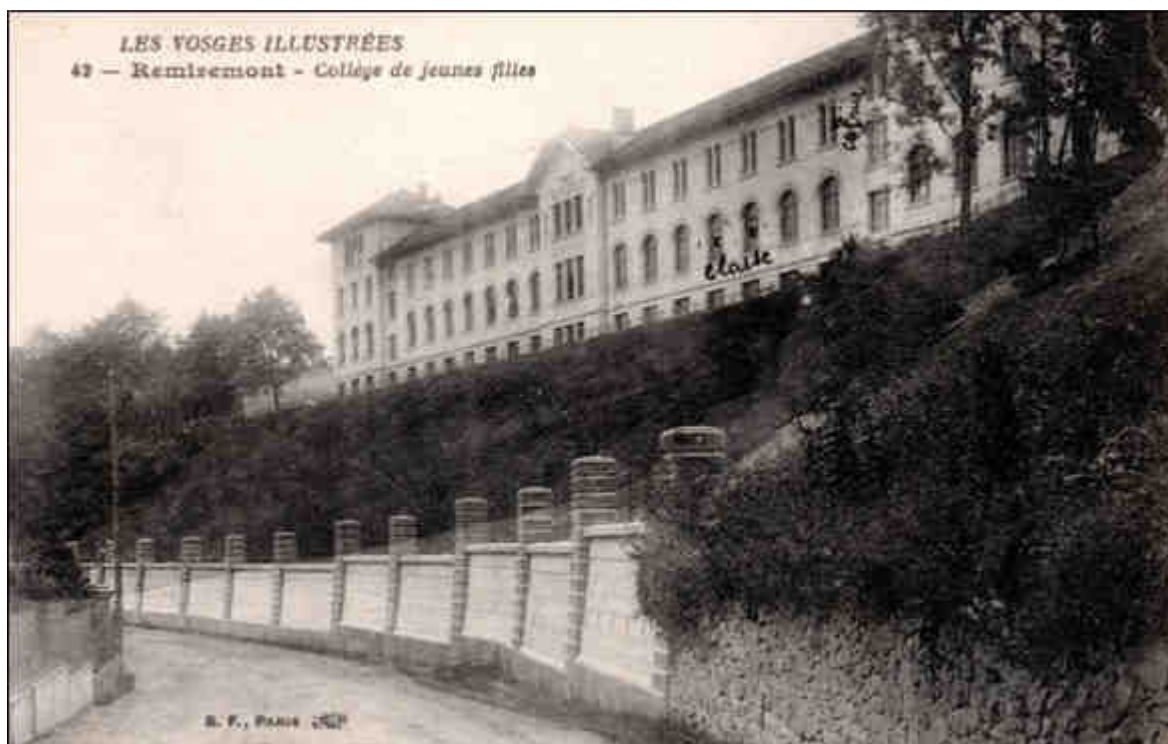
Figure 143 : Photographie du bâtiment construit en 1913-1914 pour le collège de jeunes filles de Remiremont (carte postale, début XX e siècle, coll. part.).
