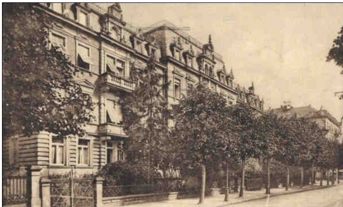
Figure 222 : Le bâtiment occupé par le pensionnat de Notre-Dame de Sion fondé à Strasbourg après 1918 (carte postale, début XX e siècle, BNUS).
