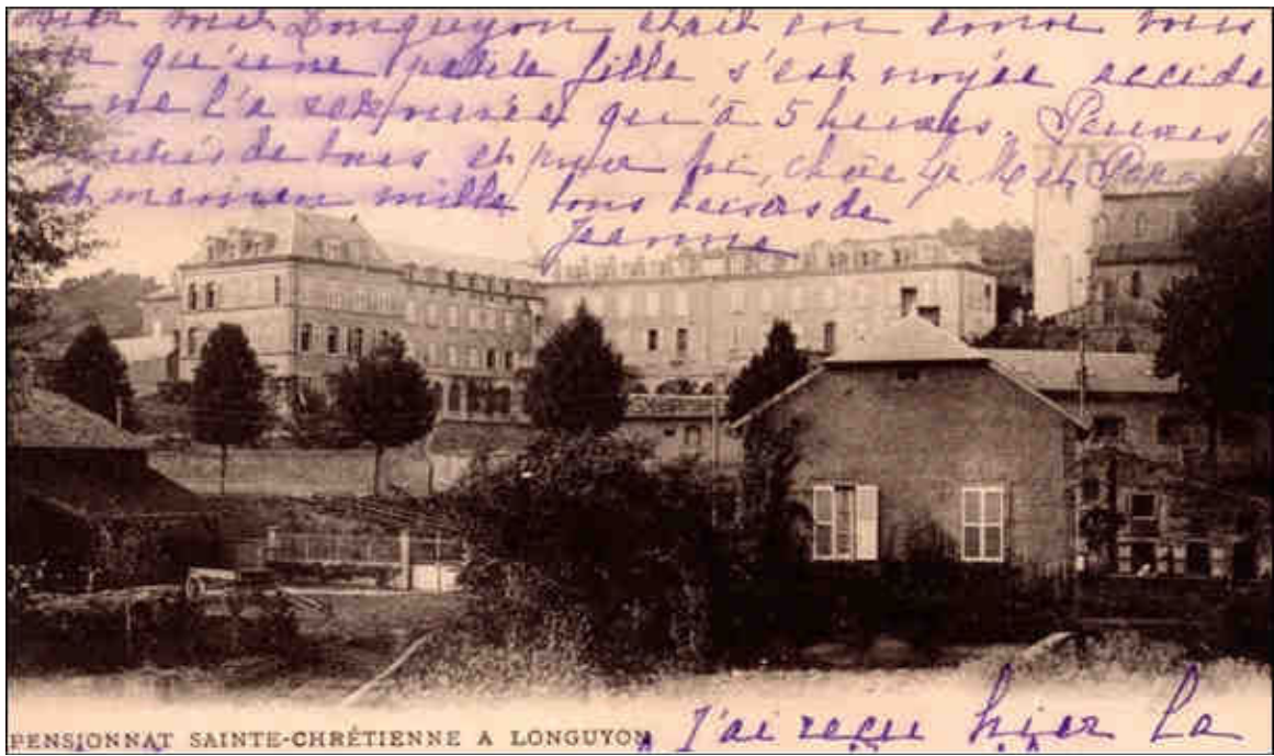
Figure 205 : Photographie, à l'arrière plan, du bâtiment du pensionnat des Sœurs de Sainte-Chrétienne à Longuyon (carte postale, vers 1900, coll. part.).
