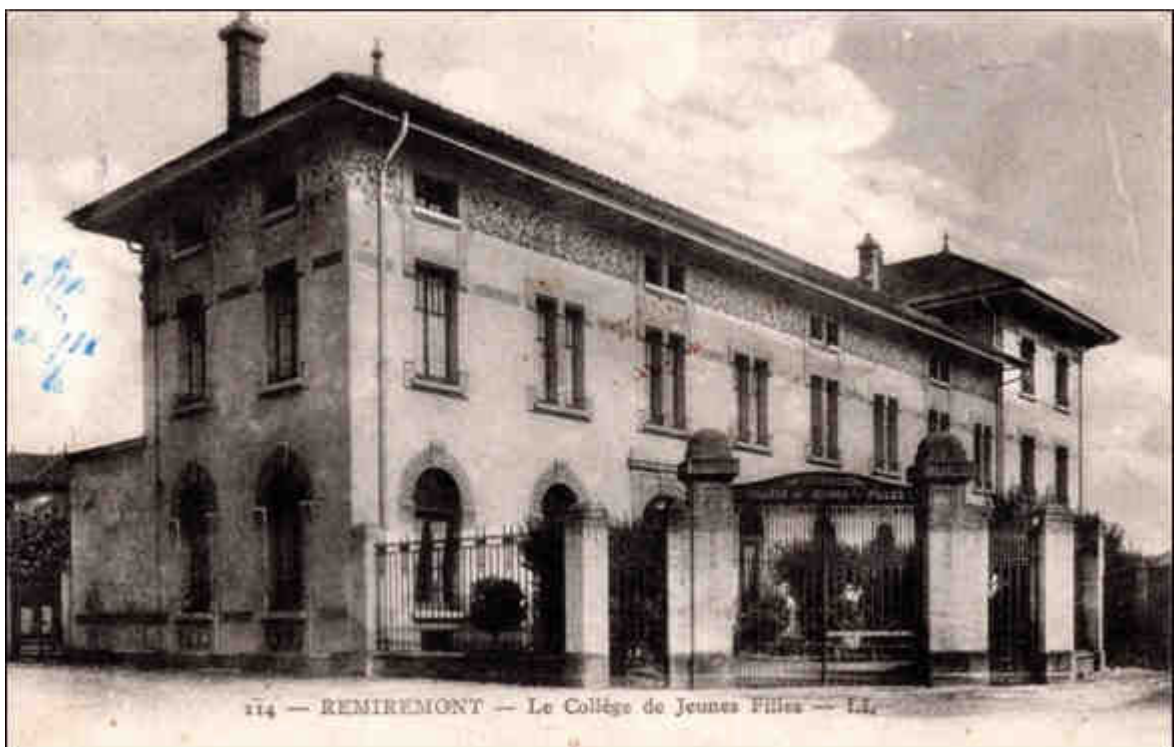
Figure 142 : Photographie de la façade principale du bâtiment construit en 1913-1914 pour le collège de jeunes filles de Remiremont (carte postale, début XX e siècle, coll. part.).
