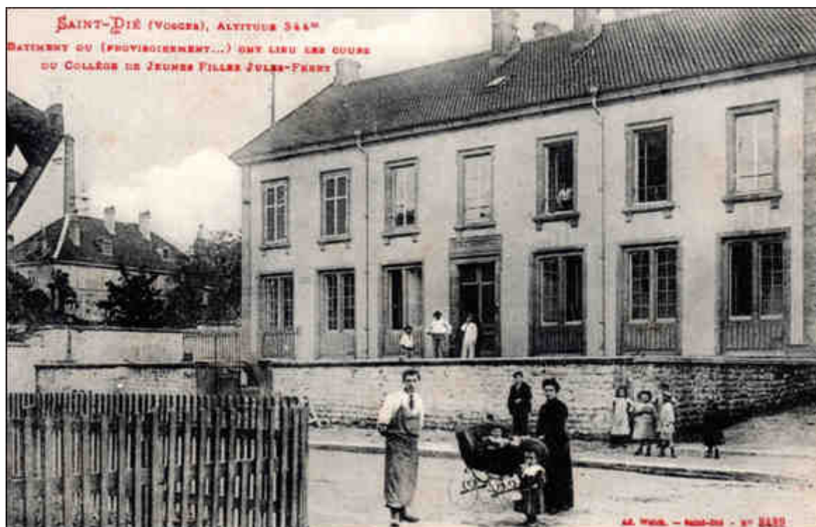
Figure 172 : Photographie du bâtiment accueillant le collège de jeunes filles de Saint-Dié jusqu'en 1923 (carte postale, début XX e siècle, coll. part.).
