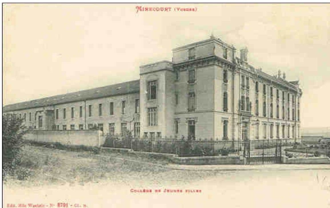
Figure 140 : Photographie du bâtiment construit en 1907 pour le collège de jeunes filles de Mirecourt : difficile de trouver le bon angle pour la prise de vue... (carte postale, début XX e siècle, coll. part.).
