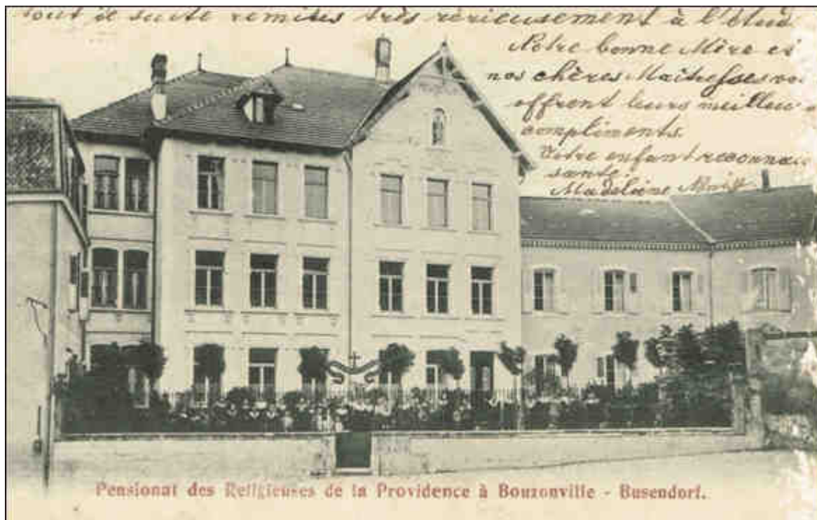
Figure 150 : Photographie du bâtiment de l'école supérieure de filles des Sœurs de la Providence de Peltre à Bouzonville : la partie centrale est une construction nouvelle bâtie vers 1900 (carte postale, vers 1900, coll. part.).
