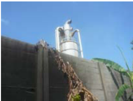
Photos 79 et 80: Cyclone d'aspiration de sciures issues de ses activités de transformations de bois
