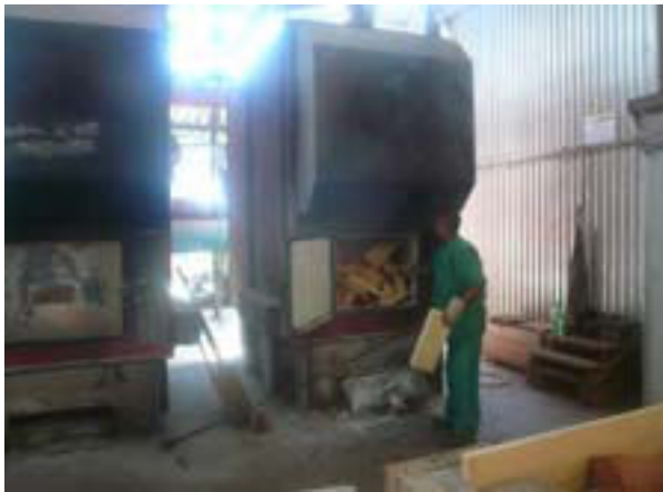
Photos 81 et 82: Utilisations de rebuts de bois de sciage pour faire fonctionner les chaudières
