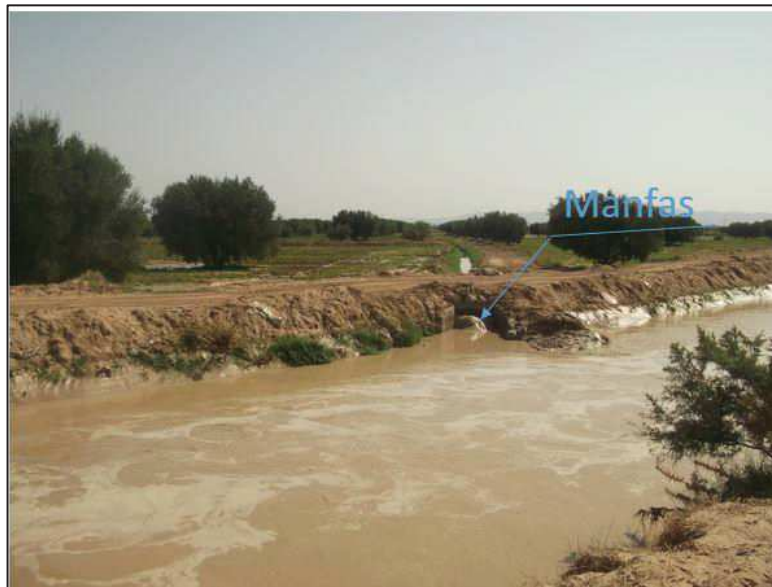
Figure 18. Manfas au niveau d'un canal en terre
