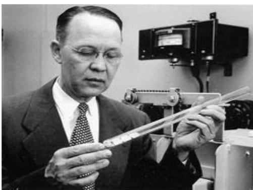
**Figure VI-2** : Calvin Fuller des laboratoires Bell diffuse du bore dans du silicium pour créer la première cellule solaire. Source : *American Physical Society*
