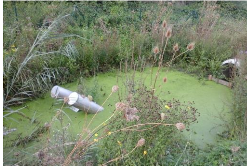
FIGURE 114: COMBLEMENT DE LA MARE DE SEDIMENTATION
