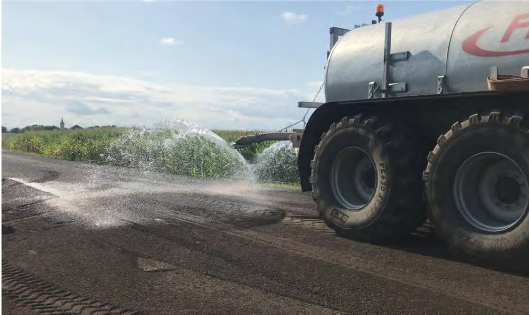
*Figure V.23 Humidification de la couche d'AE*
