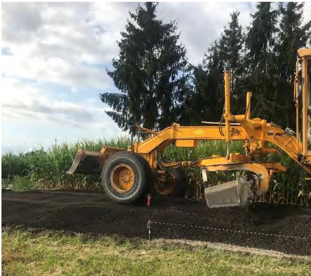
*Figure V.21 Répandage des AE*
