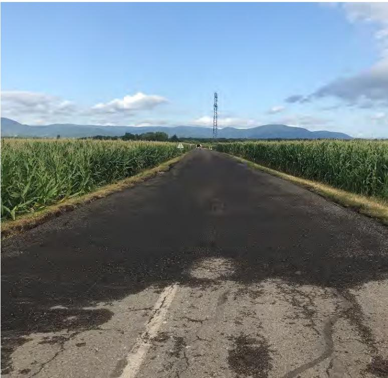
*Figure V.27 Couche d'AE compactée de la section expérimentale ORRAP n°1 à la jonction avec la chaussée existante*
