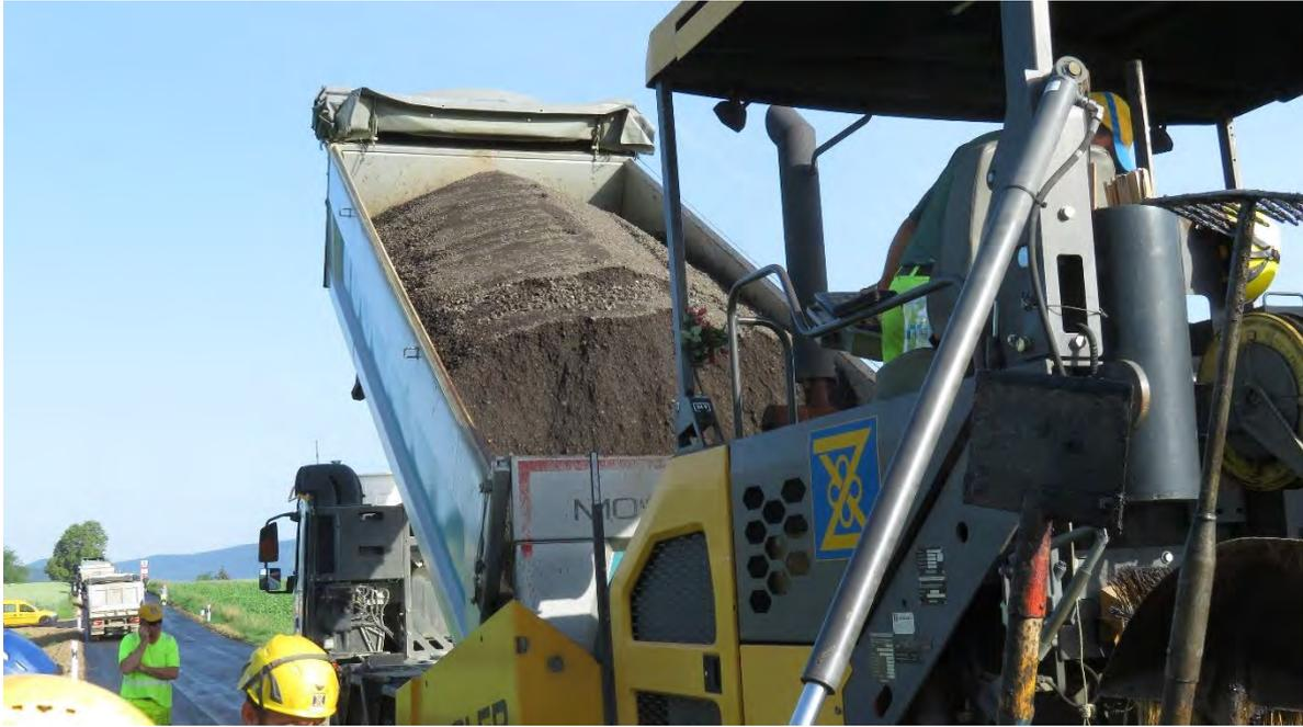
*Figure V.11 Introduction des AE dans le finisseur*
