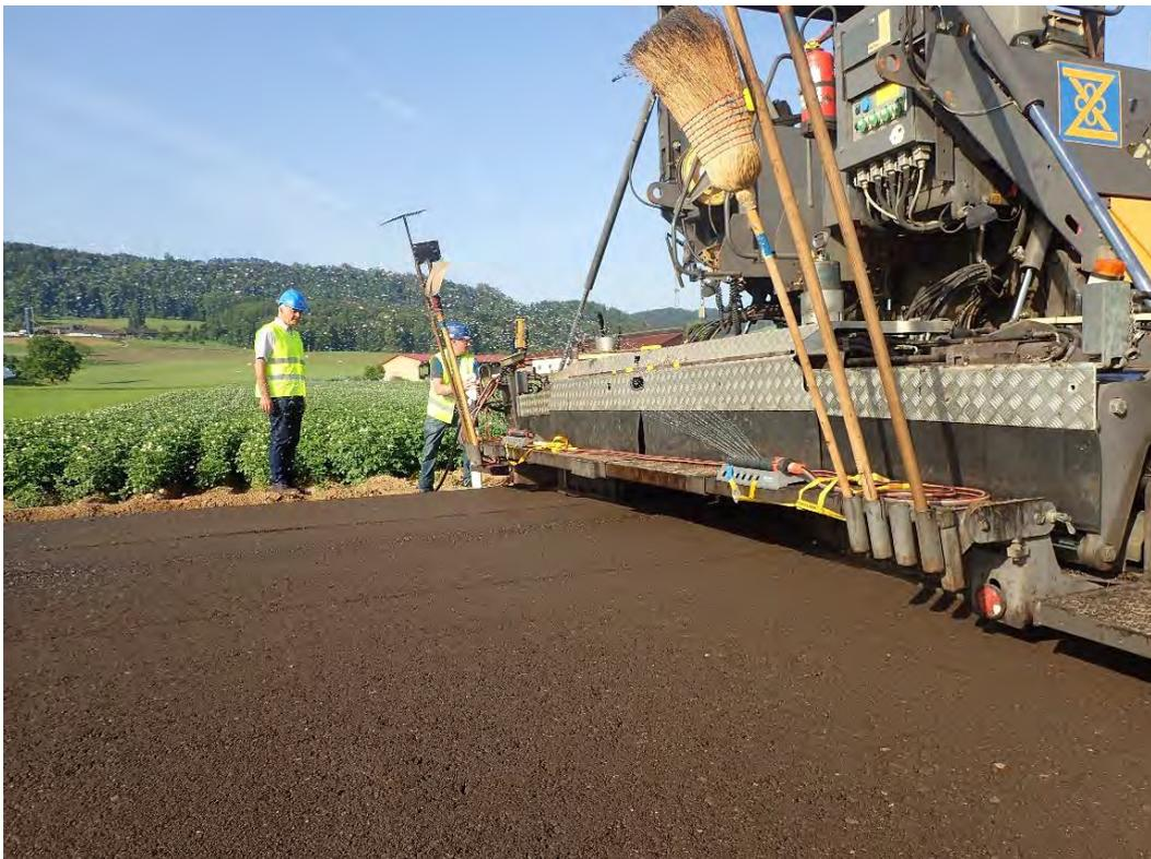
*Figure V.14 Humidification des AE après ré pandage*
