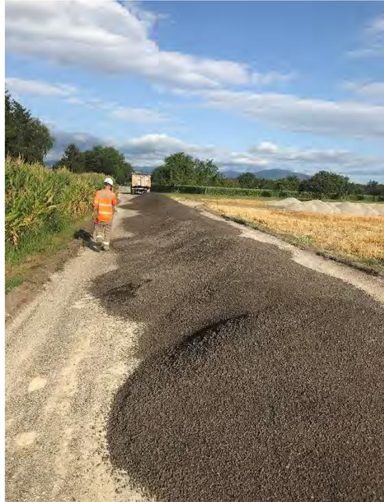
*Figure V.20 AE déversés sur la chaussée*
