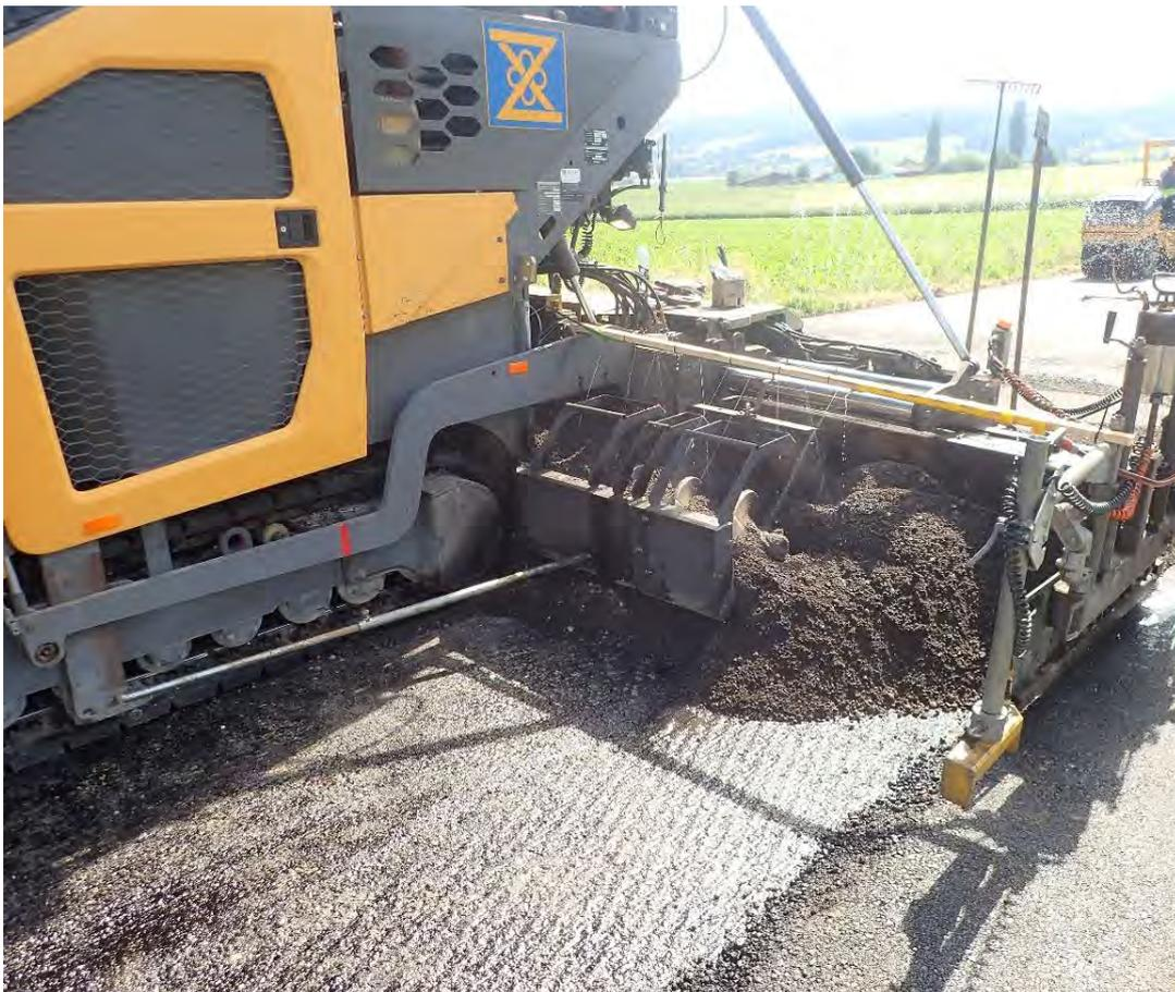
*Figure V.12 Humidification des AE avant répannage*
