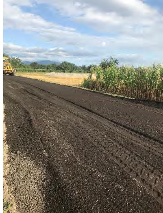
*Figure V.22 Couche d'AE lissée*
