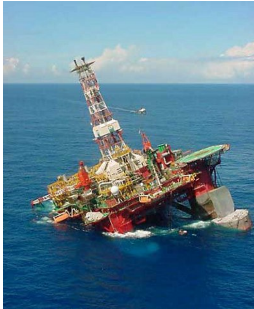
FIGURE 1.16 – Structure offshore détruite par des VIV.
