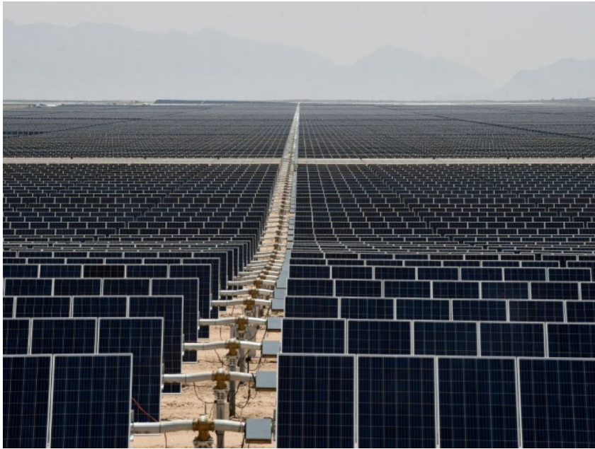
FIGURE 1.3 – Parc photovoltaïque de Villanueva dans l'état de Coahuila au Mexique. Photographie : Alfredo Estrella - AFP.
