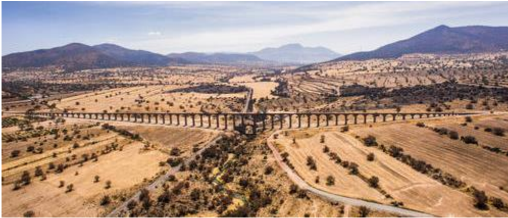
Figure 43 Aqueduc du Prêtre Tembleque, Otumba, Mexique.
