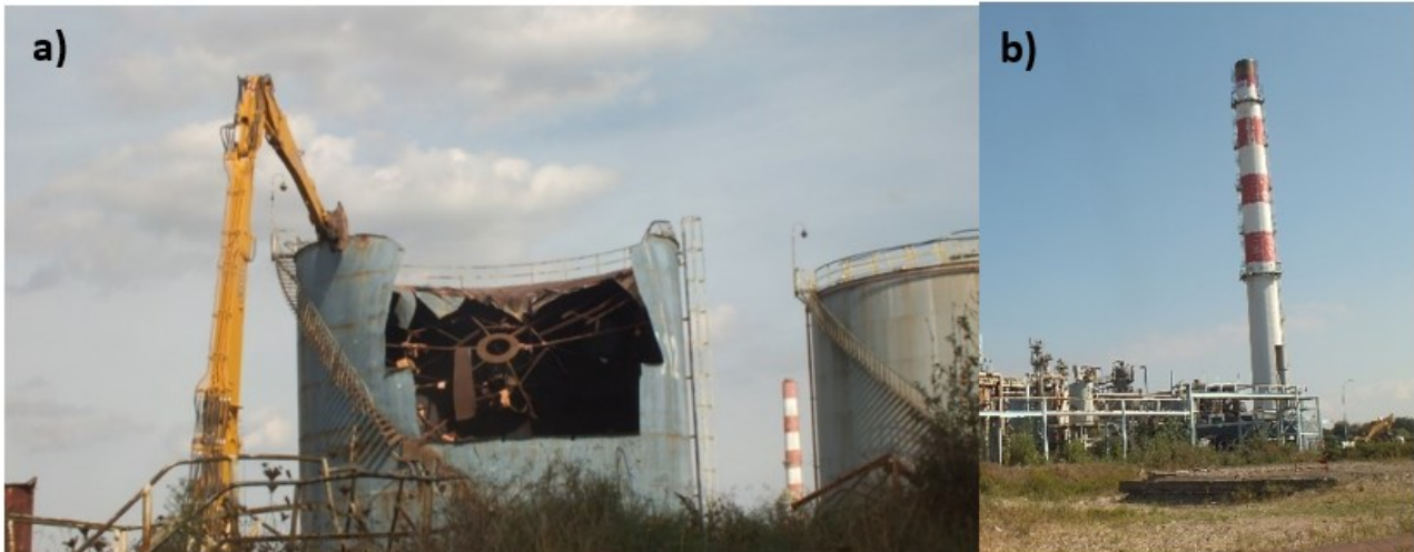
Figure 20 : Démantèlement des installations de la raffinerie de Reichstett
