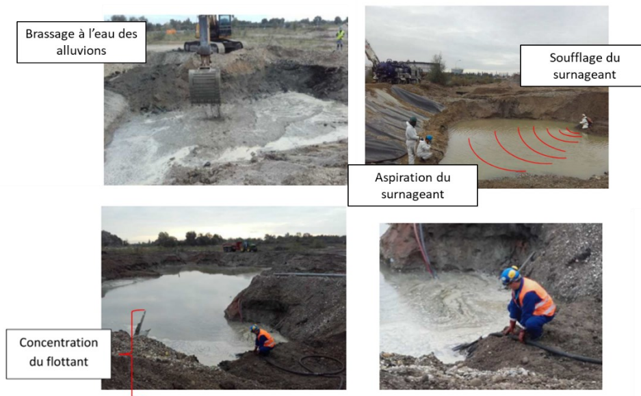
Figure 22 : Synthèse des différentes étapes de dépollution des eaux et des alluvions
