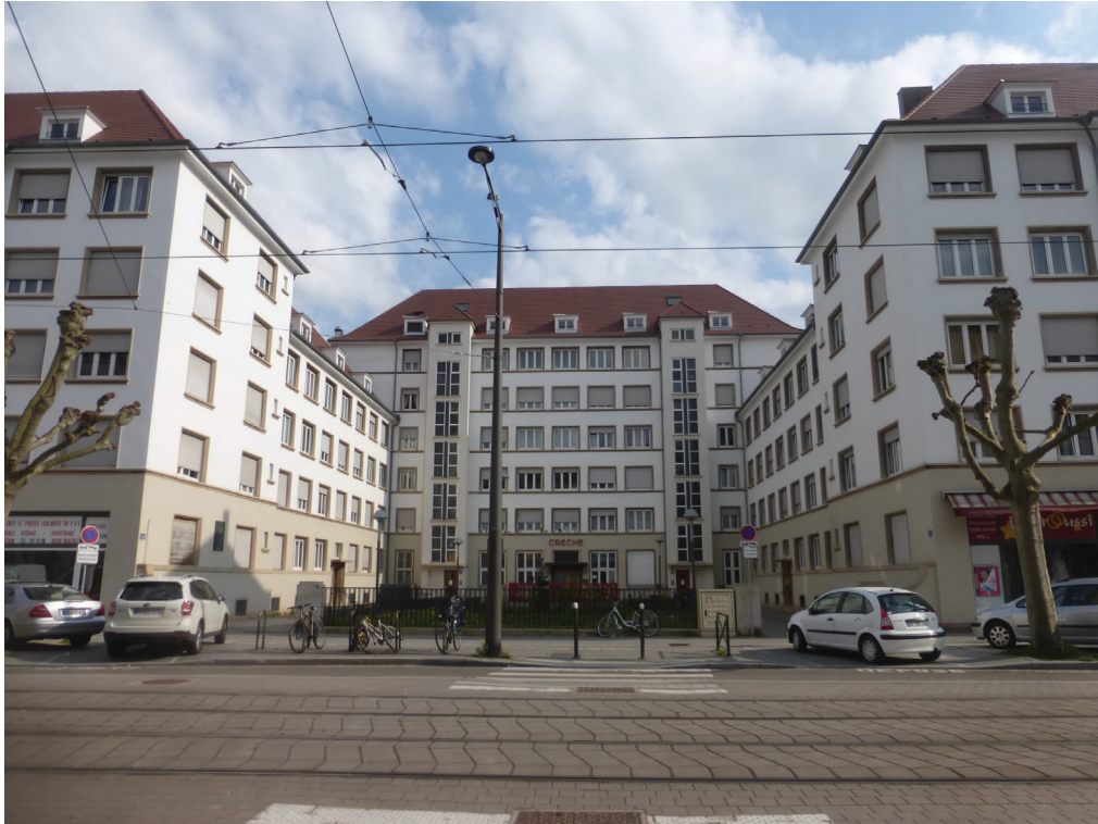
FIG. 6.15 : Vue de la crèche de la cité Georges Risler, plus grande réalisation de l'Office public d'Habitation à Bon Marché pendant l'entre-deux-guerres ( https://www.archi-wiki.org/index.php?curid=57657 )
