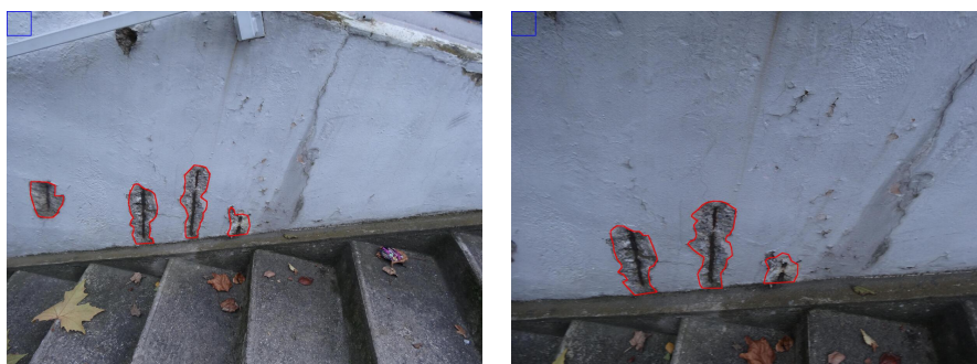
(a) Exemples issus du tunnel piéton (pris à l'échelle 1/4)
