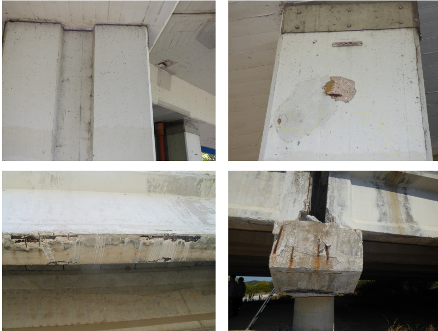
FIGURE 2.3 – Exemples extraits de la base CODEBRIM et présentant des fers apparents, à différentes échelles et sous différents angles de prise de vue.
