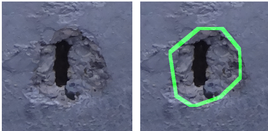
(a) Exemple de fer apparent
