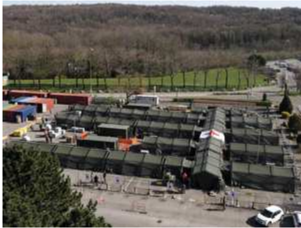
Photo 8 : Hôpital militaire installé sur le parking du CHEM
