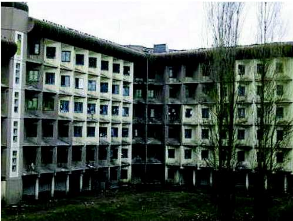
Figure 4 : Bâtiment des hommes vu de la cour intérieure. (56)
