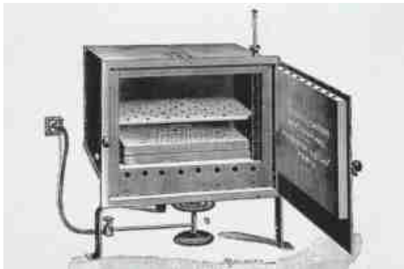
Figure 10 : Gravure Baladiez illustrant un stérilisateur d'instrument conçu vers 1900 par Poupinel
