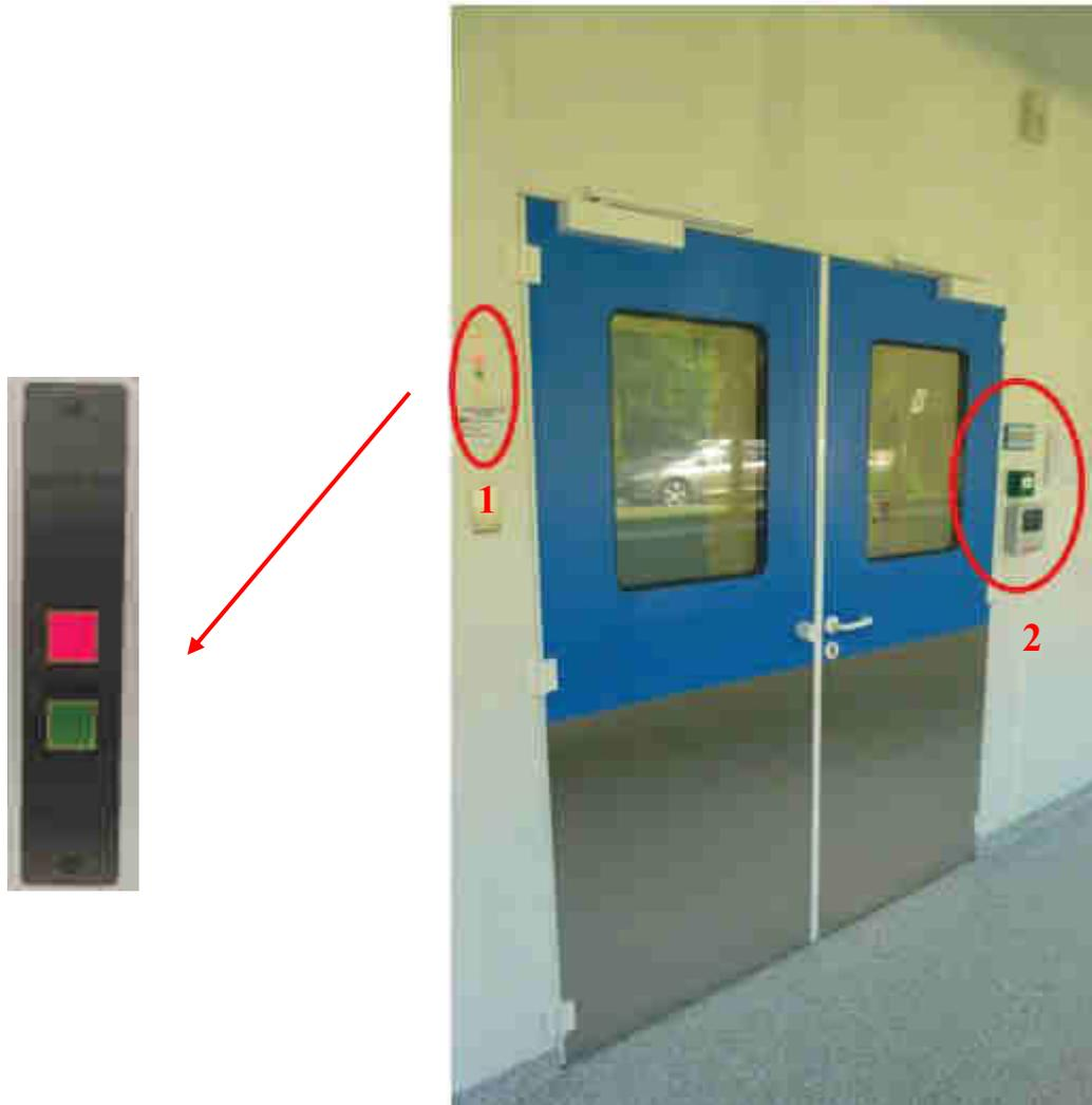
**Figure 5 :** *Porte d'un SAS d'accès en ZAC, entourage 1 – témoin lumineux, entourage 2 - système d'ouverture (source : personnelle)*
